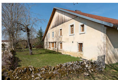
Façade sud, vue en enfilade. Phot. Sonia Dourlot IVR43_20192500338NUC4A
