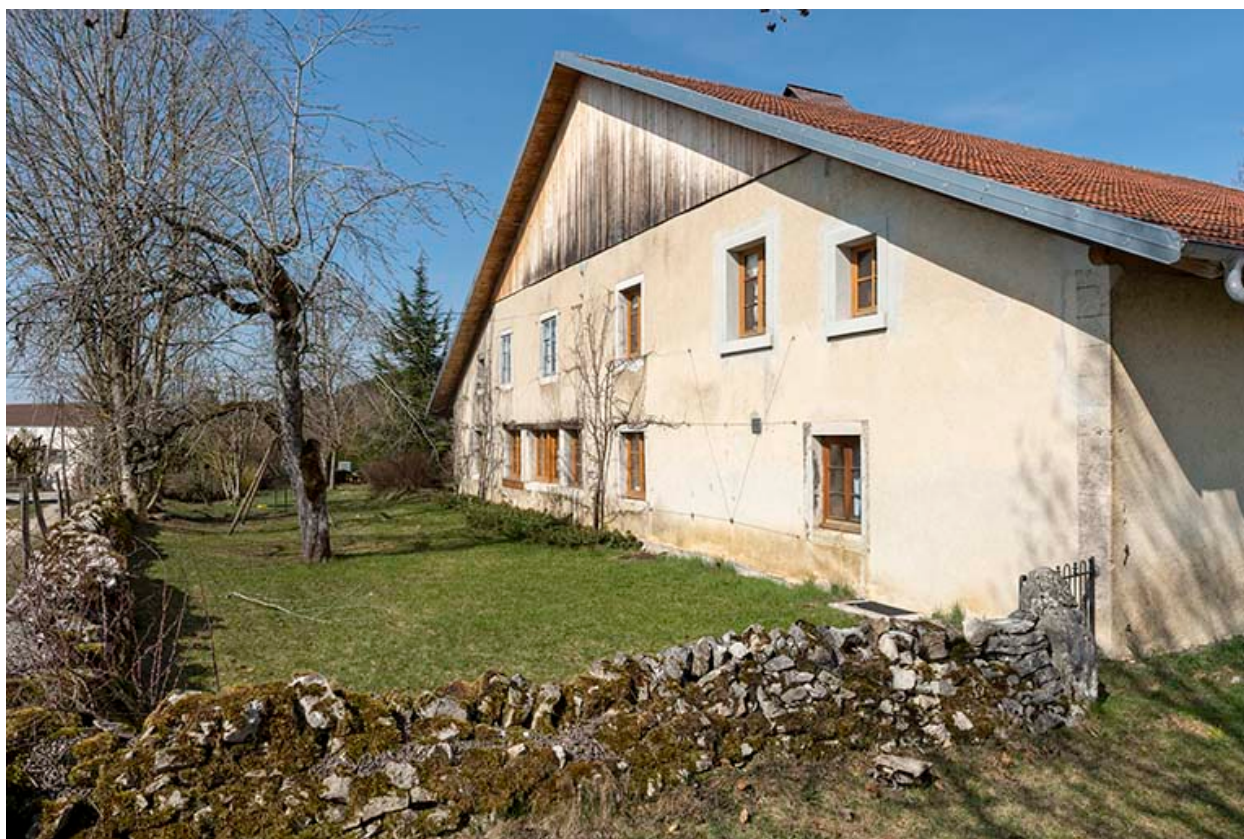
Façade sud, vue en enfilade.
