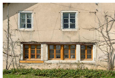
Façade sud : fenêtre multiple de l'atelier. Phot. Sonia Dourlot IVR43_20192500341NUC4A
