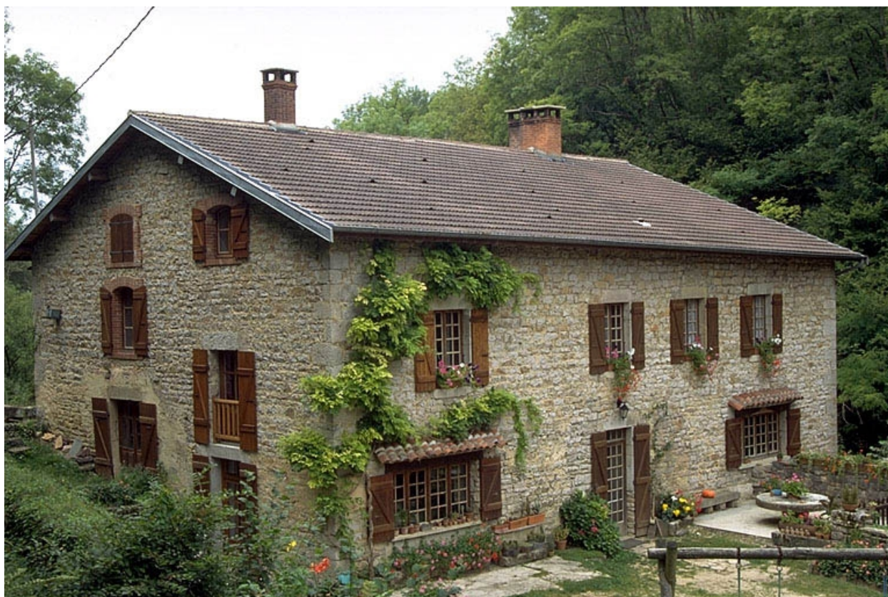
Façades antérieure et latérale gauche.
