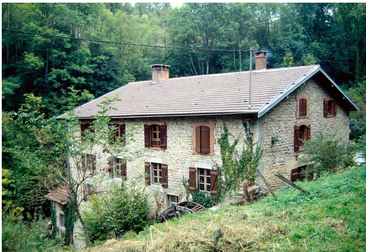
Façades postérieure et latérale gauche.
