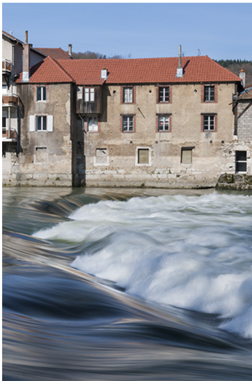
Façade est de l'atelier de menuiserie.
