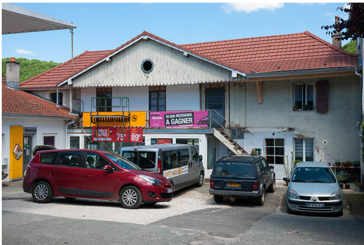
Façade ouest (ancien atelier de menuiserie).
