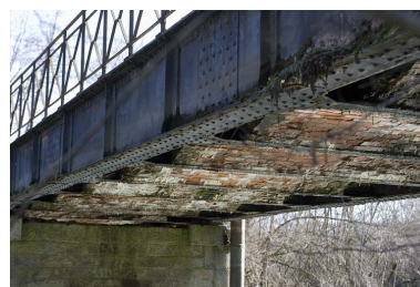
Voûtes en face inférieure du tablier. Phot. Yves Sancey IVR43_20073900074NUCA
