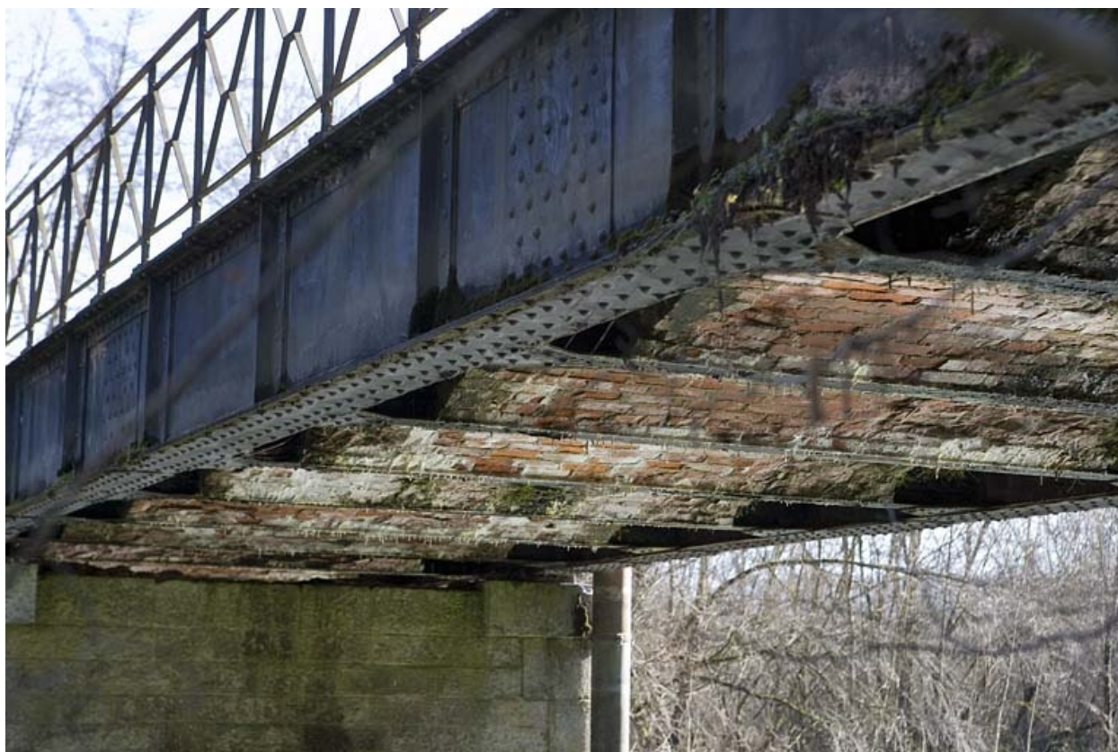
Voûtains en face inférieure du tablier.
