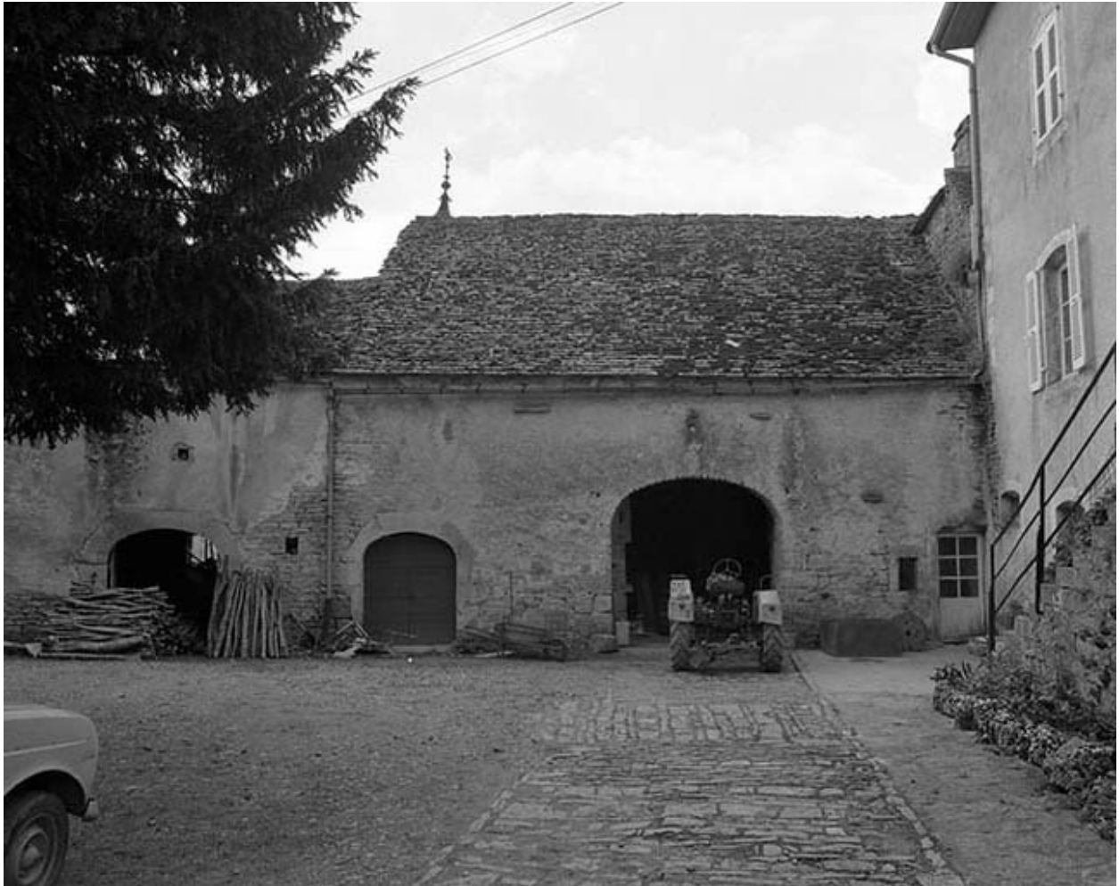
Dépendances : élévation sur cour de face.
