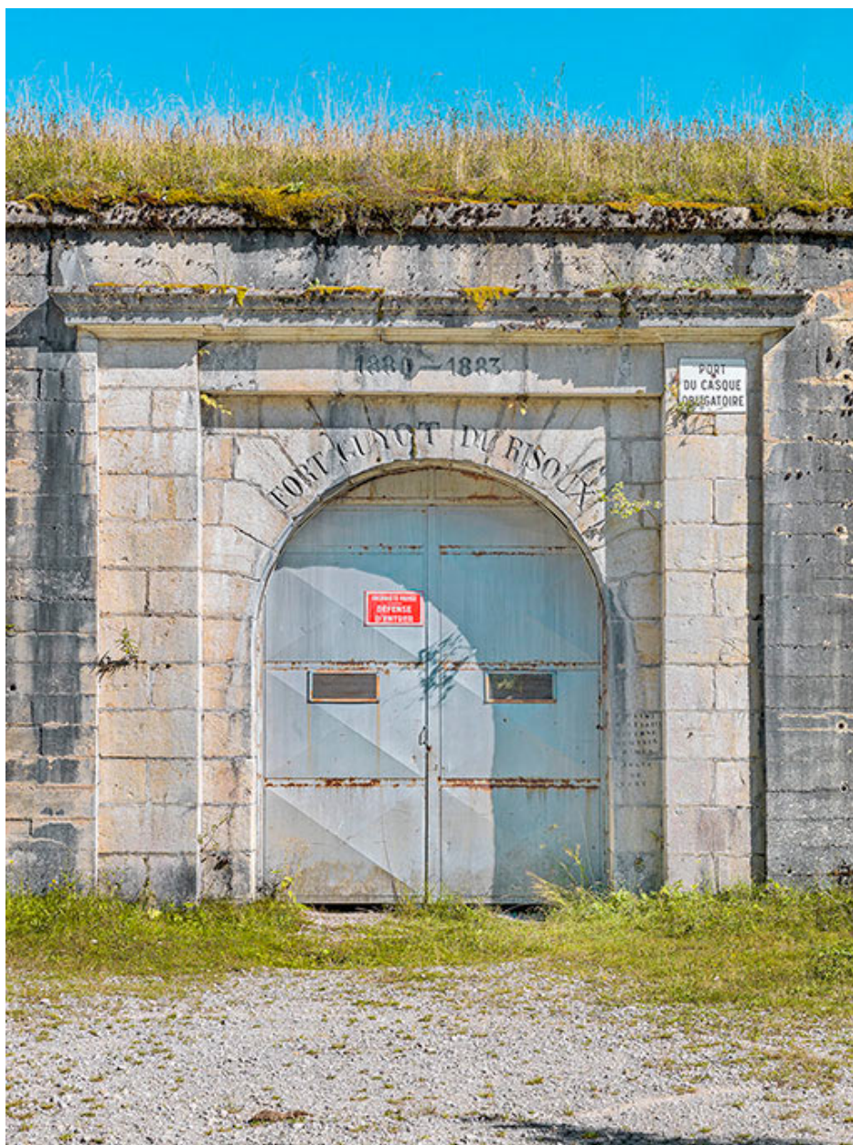
Porte du fort du Risoux.
