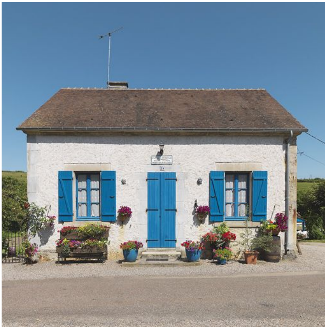
Vue de face de la maison éclusière.
