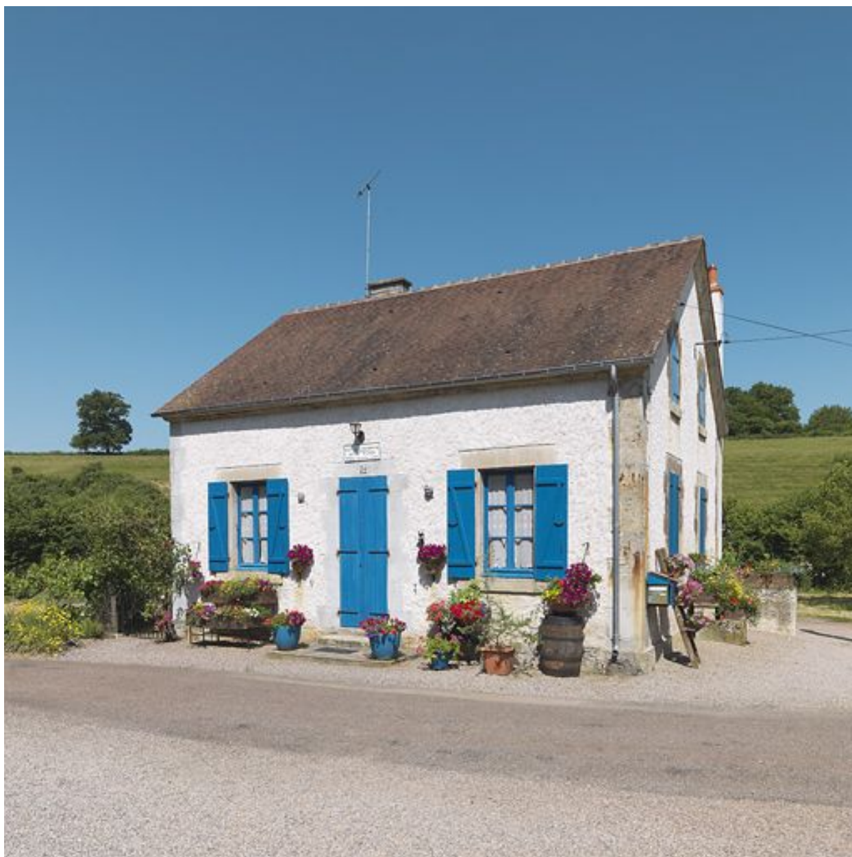
Vue de la maison éclusière de 3/4.
