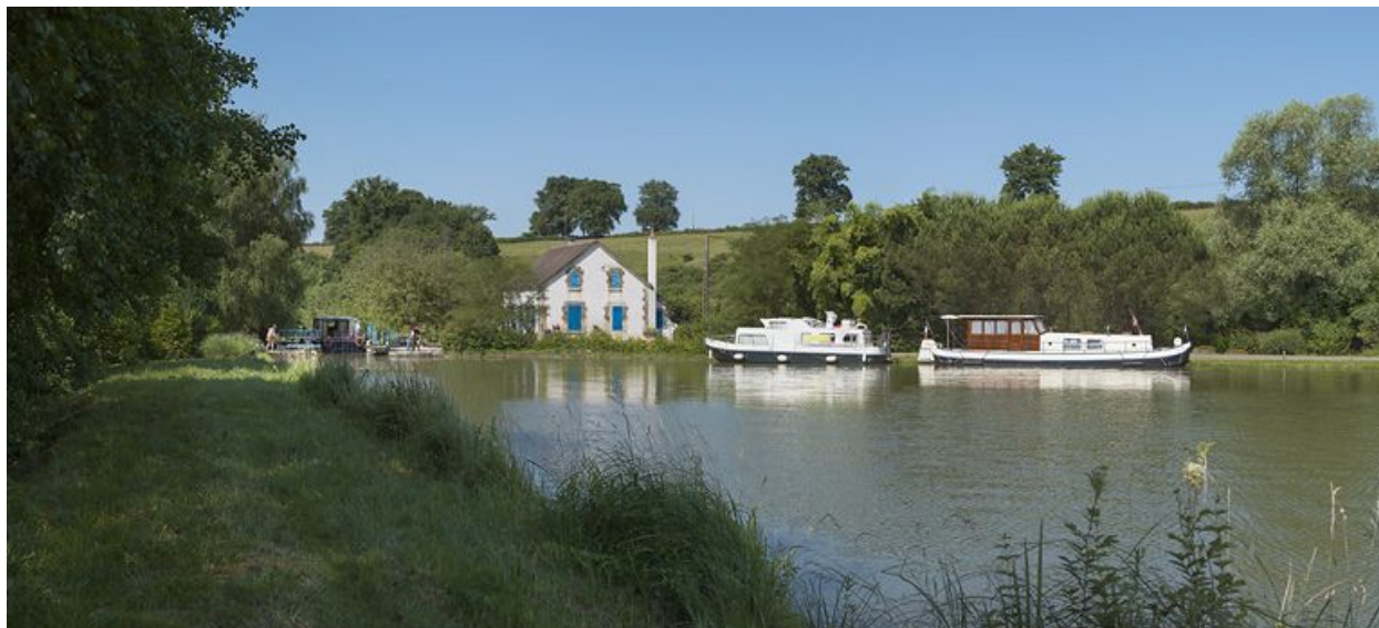
Vue d'ensemble du site, depuis l'amont.
