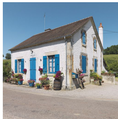
Vue de la maison éclusière de 3/4. Phot. Thierry Kuntz IVR26_20135800268NUC4A
