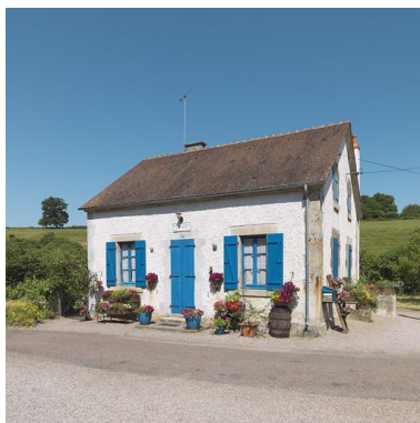
Vue de la maison éclusière de 3/4. Phot. Thierry Kuntz IVR26_20135800267NUC4A
