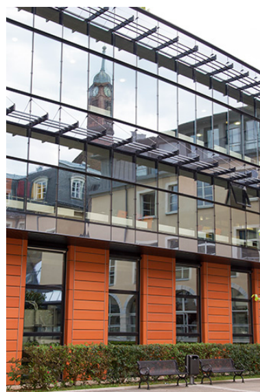
Aile Est : détail des structures.
