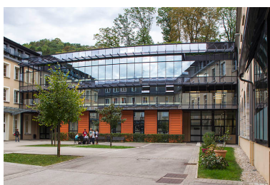
Aile Est : façade antérieure sur cour.
