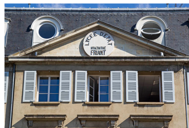
Fronton sur la façade antérieure de l'externat. Phot. Sonia Dourlot IVR43_20143900693NUC2A
