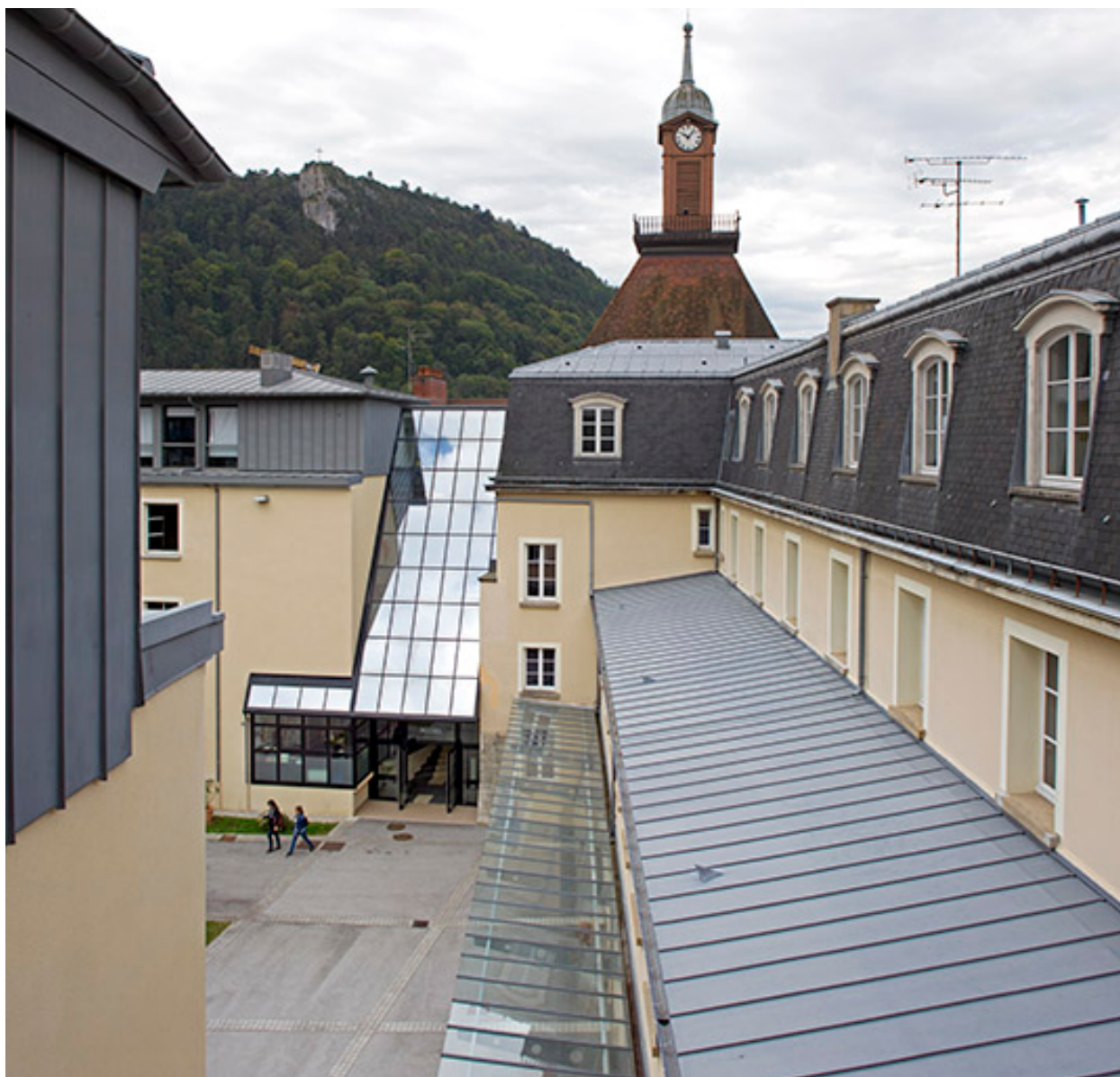
Aile Ouest : toitures at auvents.
