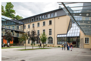
Aile Sud : détail. Phot. Sonia Dourlot IVR43_20143900710NUC2A
