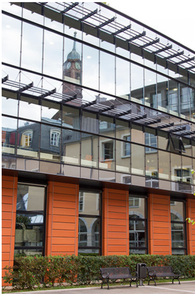
Aile Est : détail des structures.
