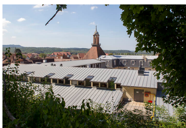
Aménagement des combles
