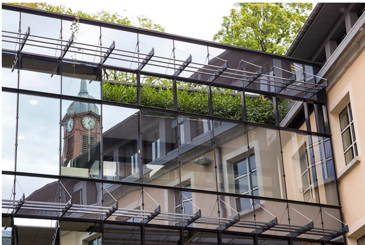
Aile Est : partie supérieure vitrée.
