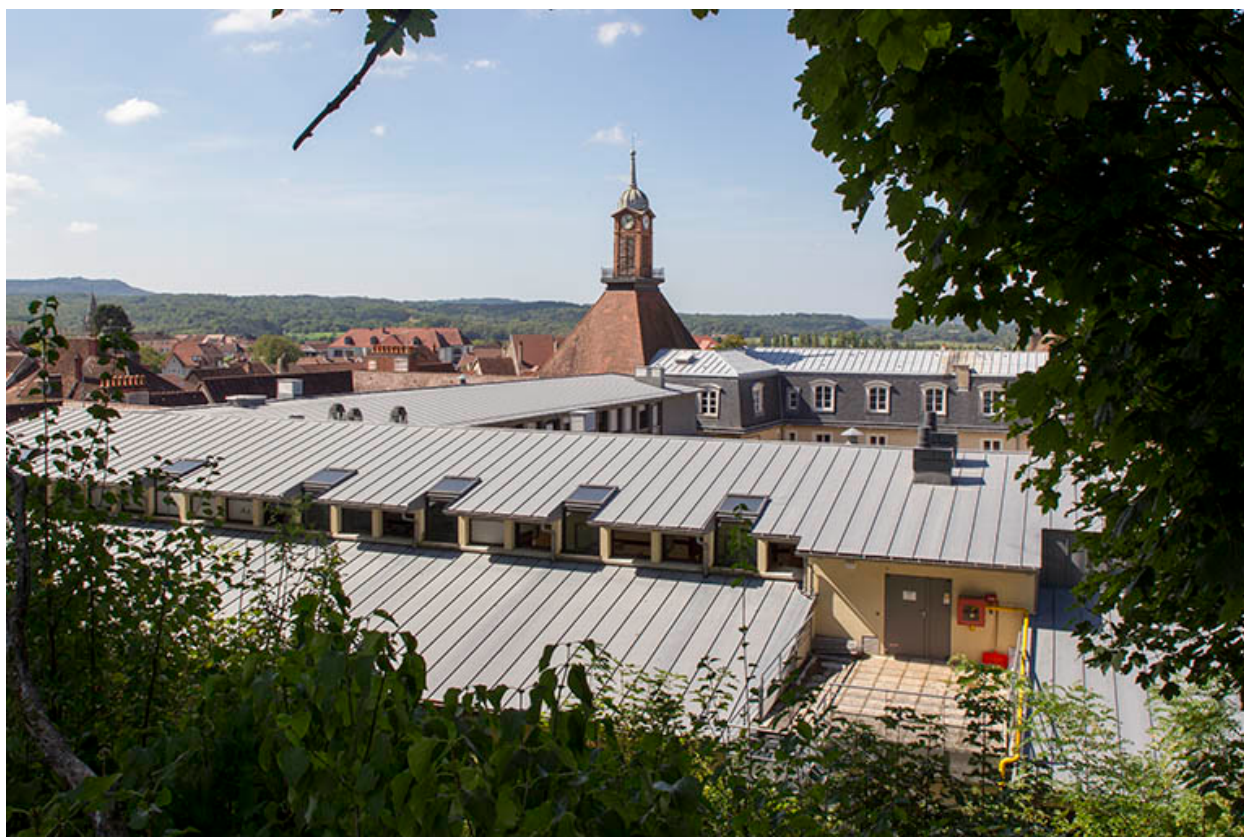
Aménagement des combles
