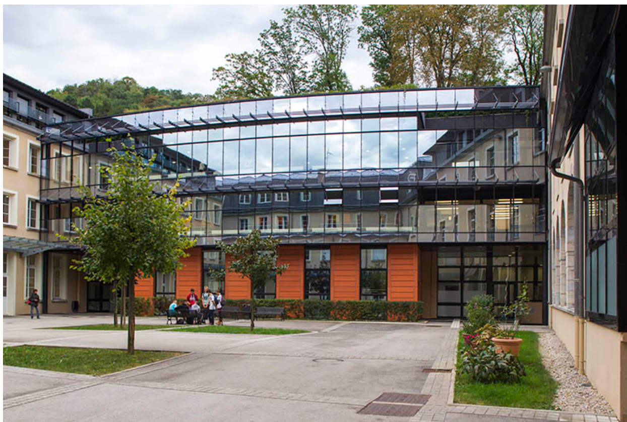
Aile Est : façade antérieure sur cour.
