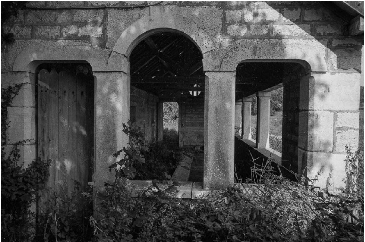
Façade latérale gauche.
