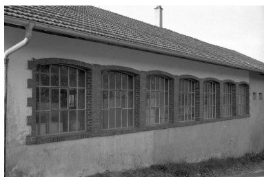
Fenêtres de la façade latérale droite. Phot. Laurent Poupard IVR43_19903900442Z
