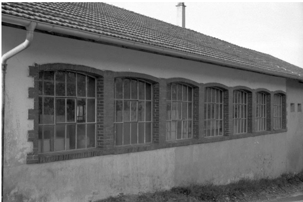
Fenêtres de la façade latérale droite.
