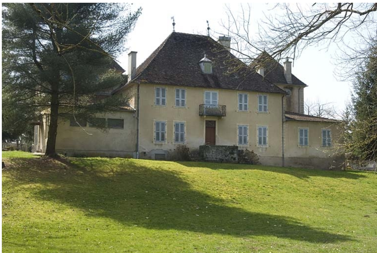
Façade postérieure du logement patronal.
