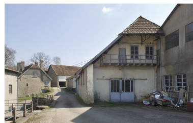
Bâtiments industriels vus depuis l'ouest.
