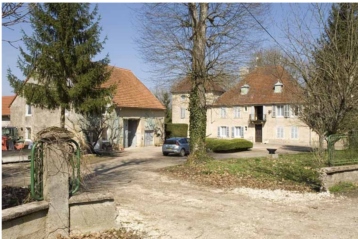
Le logement patronal et ses dépendances.
