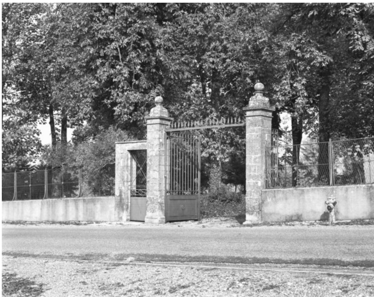
Portail d'entrée du logement patronal en 1989.
