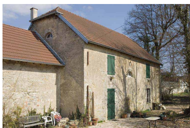
Logement ouvrier sud. Phot. Jérôme Mongreville IVR43_20097000586NUC2A
