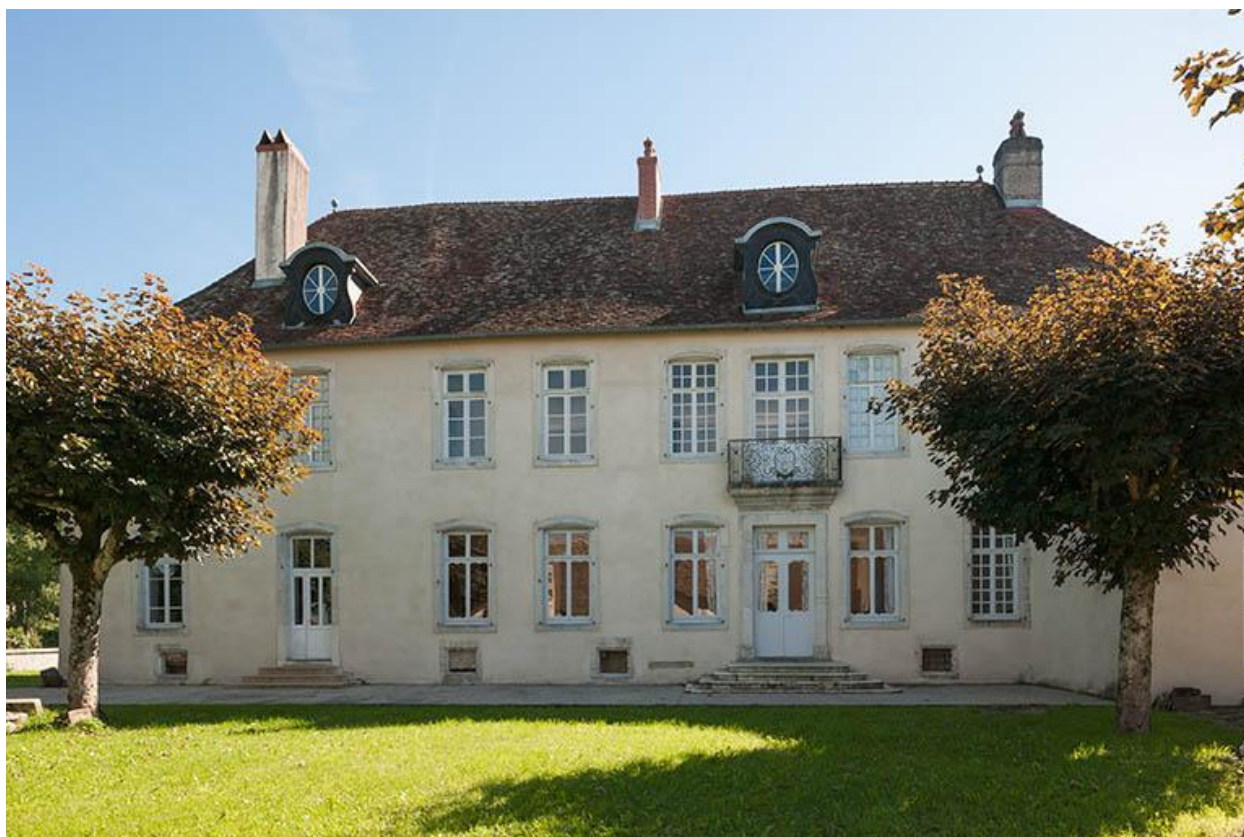
Demeure 13 rue Ménans, façade nord
