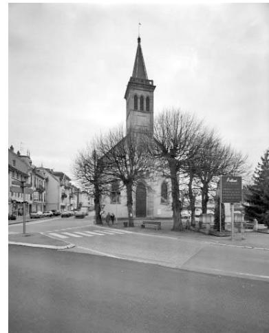
Vue d'ensemble. Phot. Jérôme Mongreville IVR43_19912500050V
