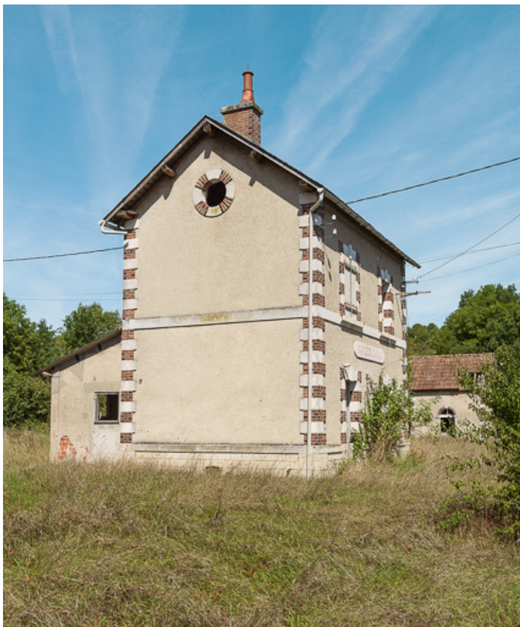
Vue d'une maison de barragiste.
