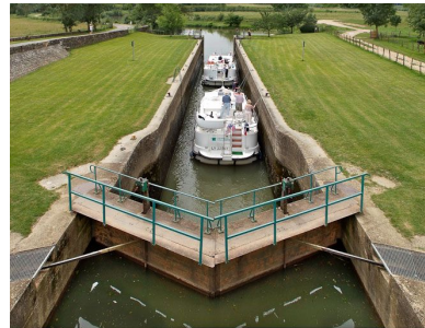
Le sas. Passage de bateaux. Phot. Jean-Luc Duthu IVR26_20120100003NUC2A
