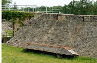
Le site d'écluse de La Truchère : digue avec allège, pont sur écluse. Phot. Jean-Luc Duthu IVR26_20120100006NUC2A
