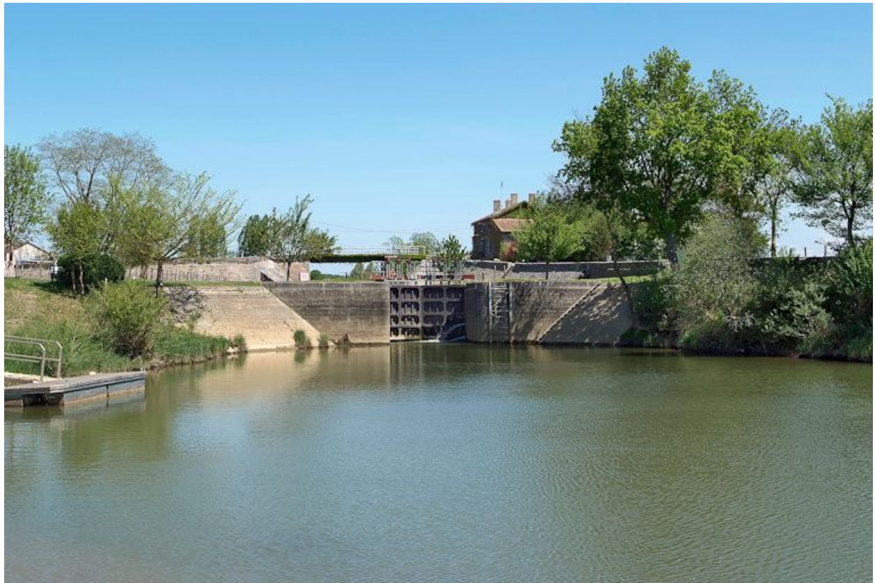
Vue d'ensemble du site d'écluse de La Truchère.
