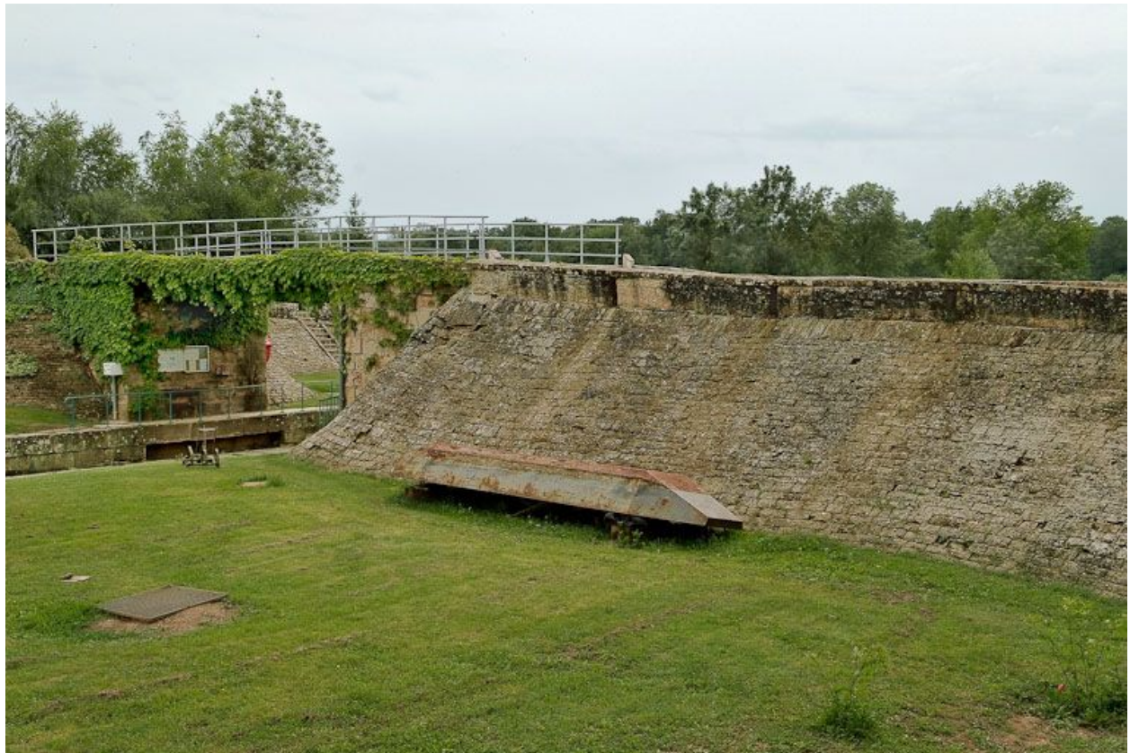
Le site d'écluse de La Truchère : digue avec allège, pont sur écluse.
