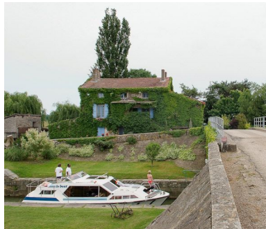
Le site d'écluse de La Truchère : le sas. A l'arrière-plan, la maison éclésièrè. Phot. Jean-Luc Duthu IVR26_20120100004NUC2A
