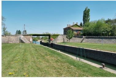
Le sas d'écluse de La Truchère. Phot. Jean-Luc Duthu IVR26_20120100002NUC2A
