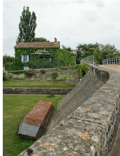
Le site d'écluse de La Truchère : digue avec allège, pont sur écluse, la maison éclésièrè en fond. Phot. Jean-Luc Duthu IVR26_20120100008NUC2A
