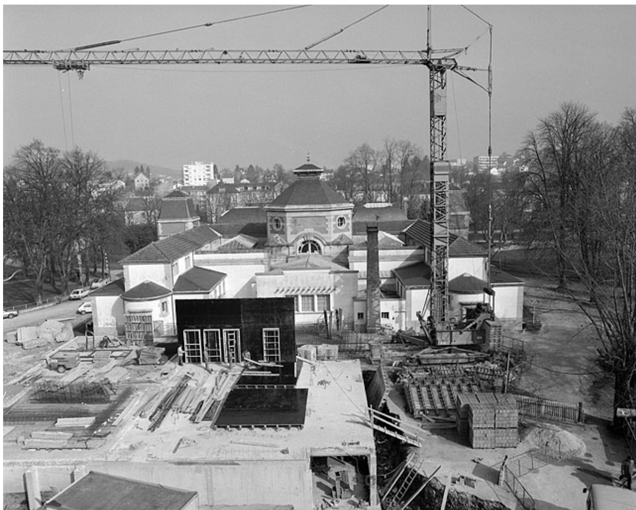
Travaux d'agrandissement, photographie prise en 1983.
