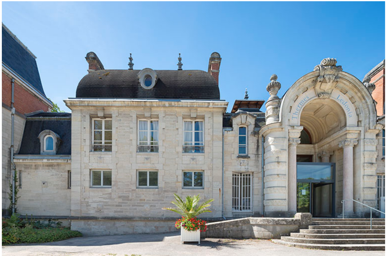
Façade principale, pavillon oriental.
