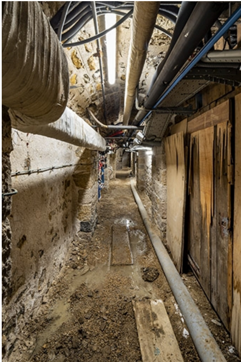
Galerie nord du sous-sol, sous le vestibule.
