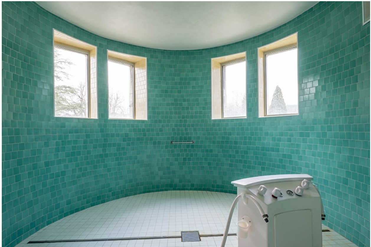
Salle de douche du pavillon d'angle nord-est.
