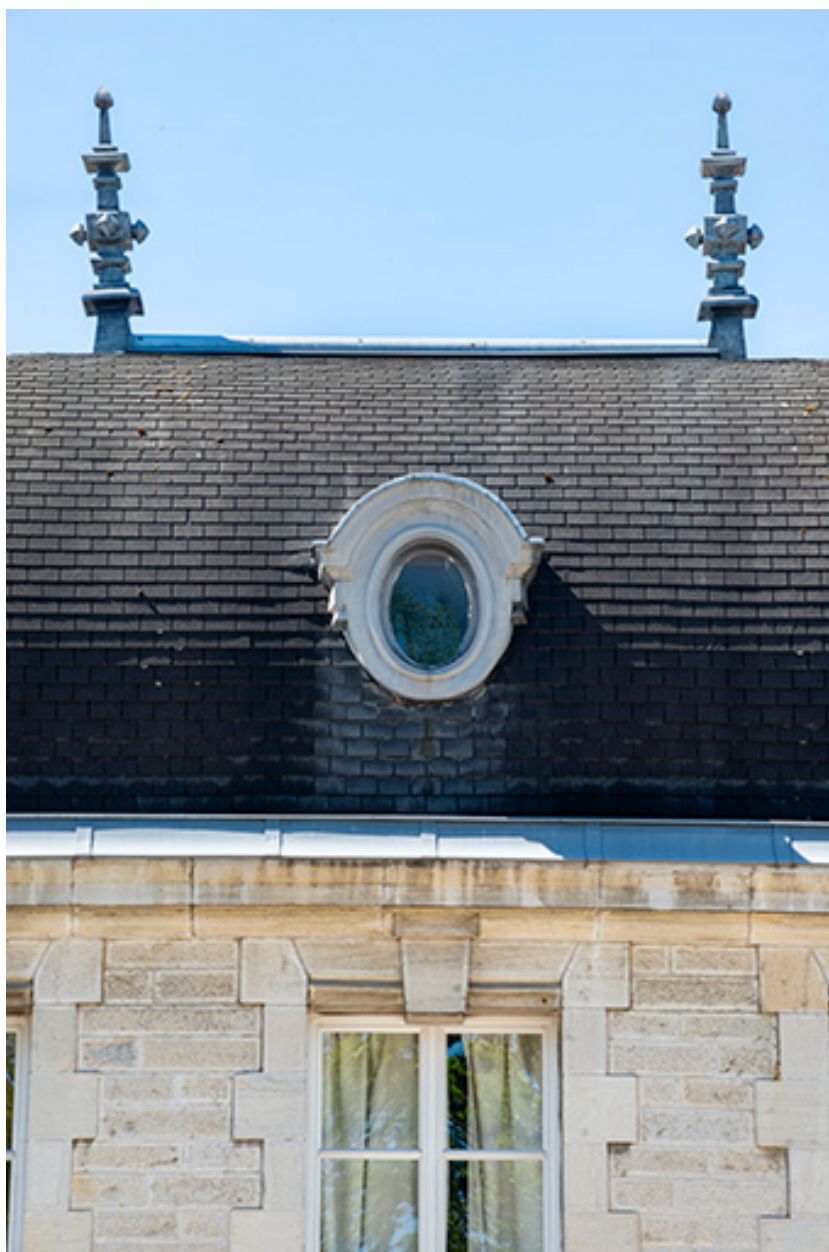
Façade principale, pavillon occidental, détail.
