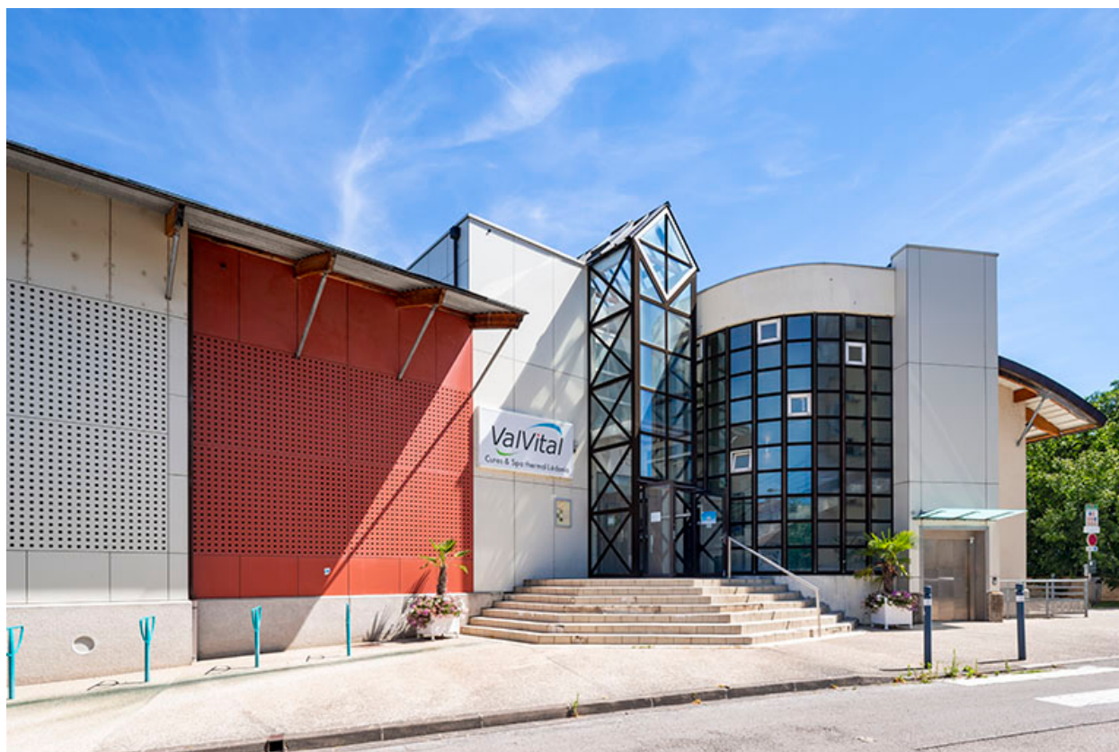
Piscine de l'extension de 1983 (à gauche).
