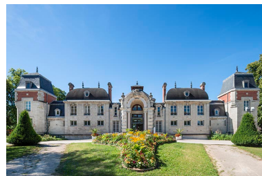
Façade principale. Phot. Jérôme Mongreville IVR43_20223900738NUC4A
