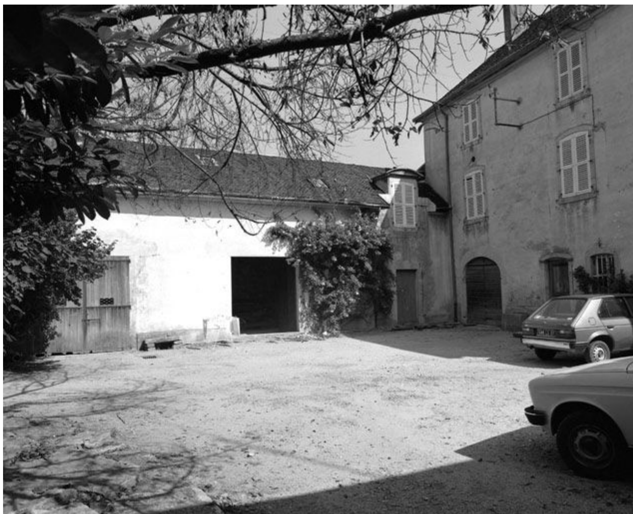
Bâtiment à gauche de la cour.
