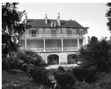
Façade postérieure vue de face. Phot. Yves Sancey IVR43_19843900351X
