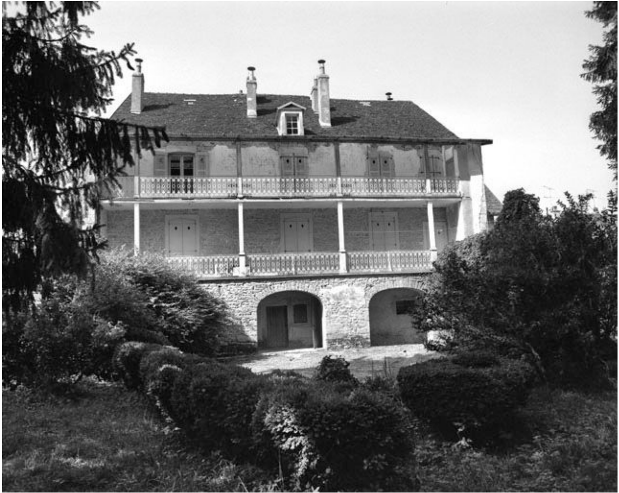
Façade postérieure vue de face.
