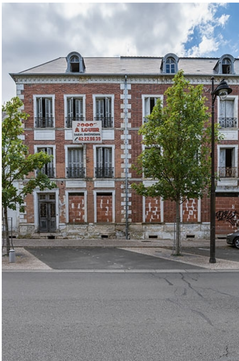
Façade de l'extension de Jules Guimard.
