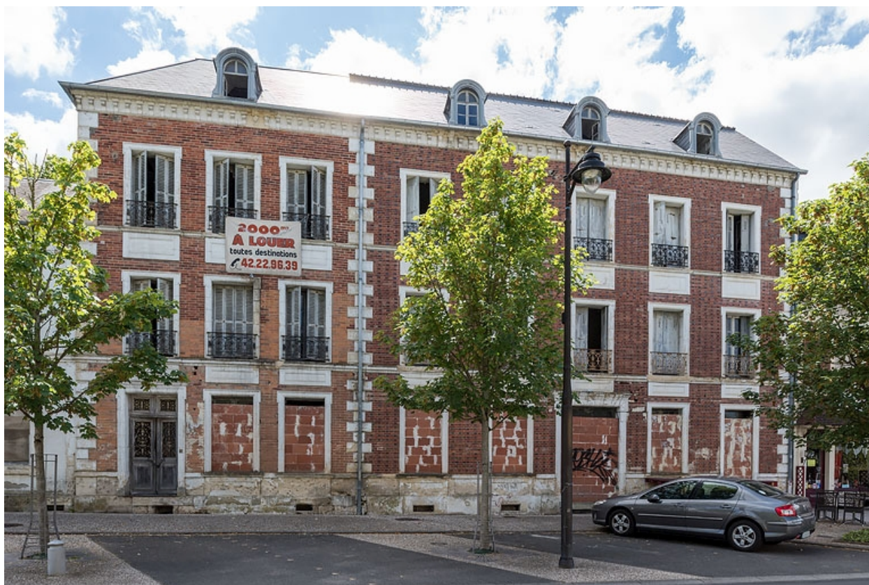
Façade de l'extension de Jules Guimard.
