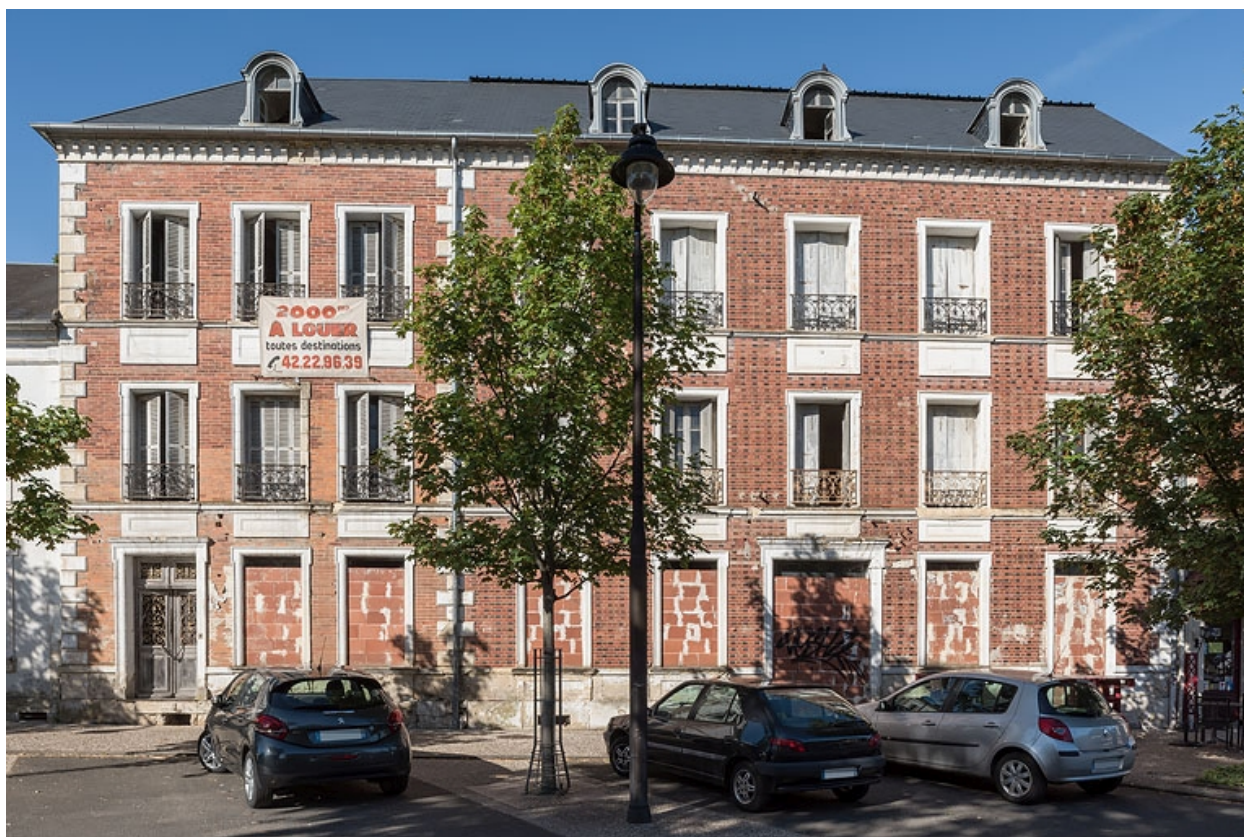
Façade de l'extension de Jules Guimard.
