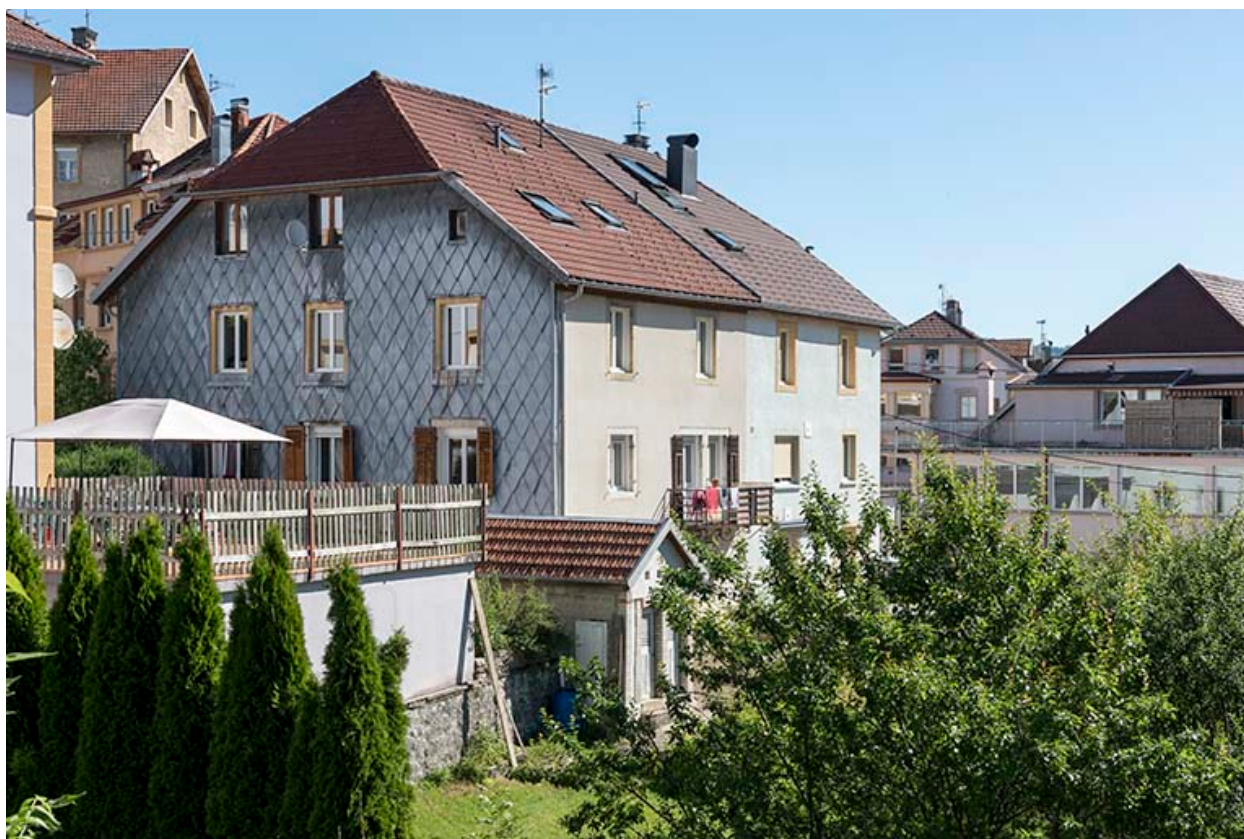
Façades postérieure et latérale droite.
