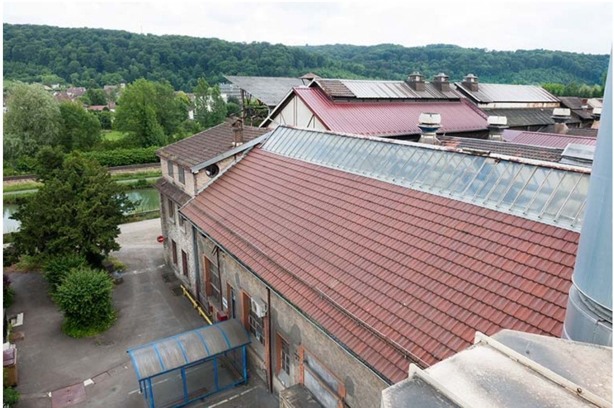
Vue plongeante sur l'ancien atelier de noyautage.
