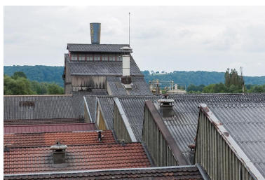
Toitures de l'usine. Phot. Jérôme Mongreville IVR43_20132500996NUC4A
