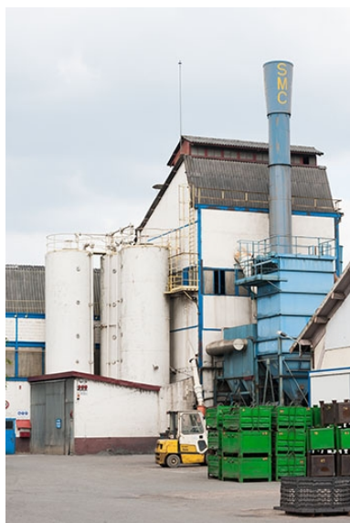
Installations de la sablerie. Phot. Jérôme Mongreville IVR43_20132500995NUC4A
