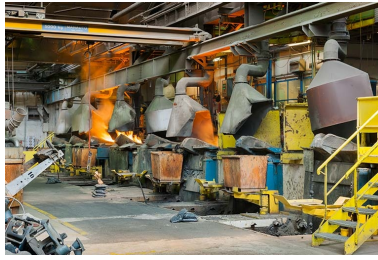
Batterie de fours à induction (3). Phot. Jérôme Mongreville IVR43_20132500953NUC4A
