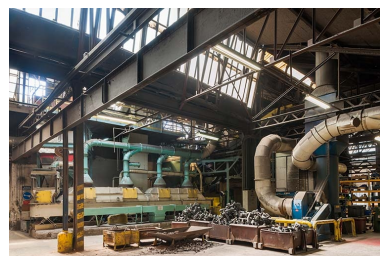
Vue d'ensemble. Ossature métallique. Phot. Jérôme Mongreville IVR43_20132500975NUC4A
