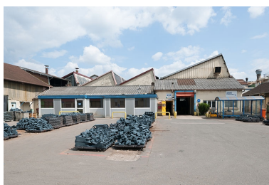
Stockage de pièces moulées dans la cour. Phot. Jérôme Mongreville IVR43_20132500994NUC4A
