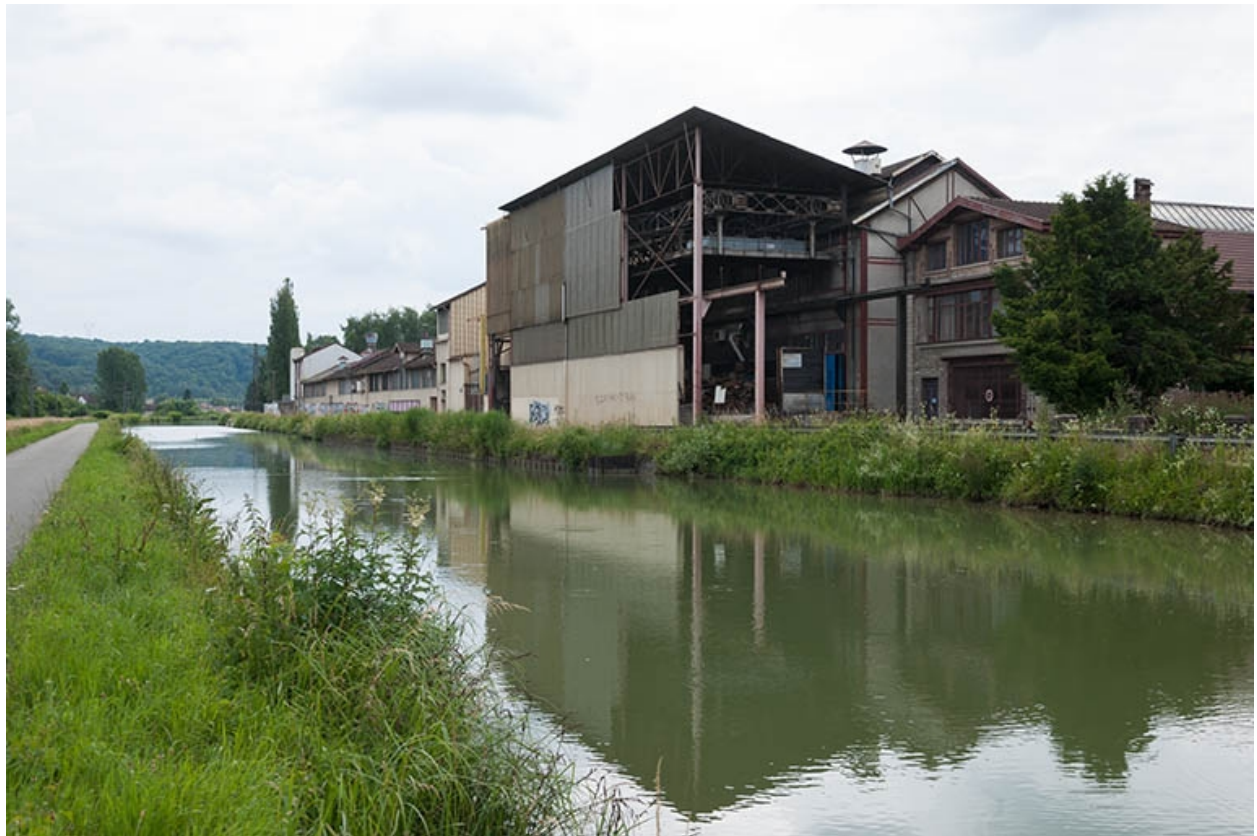
Vue d'ensemble depuis le canal.
