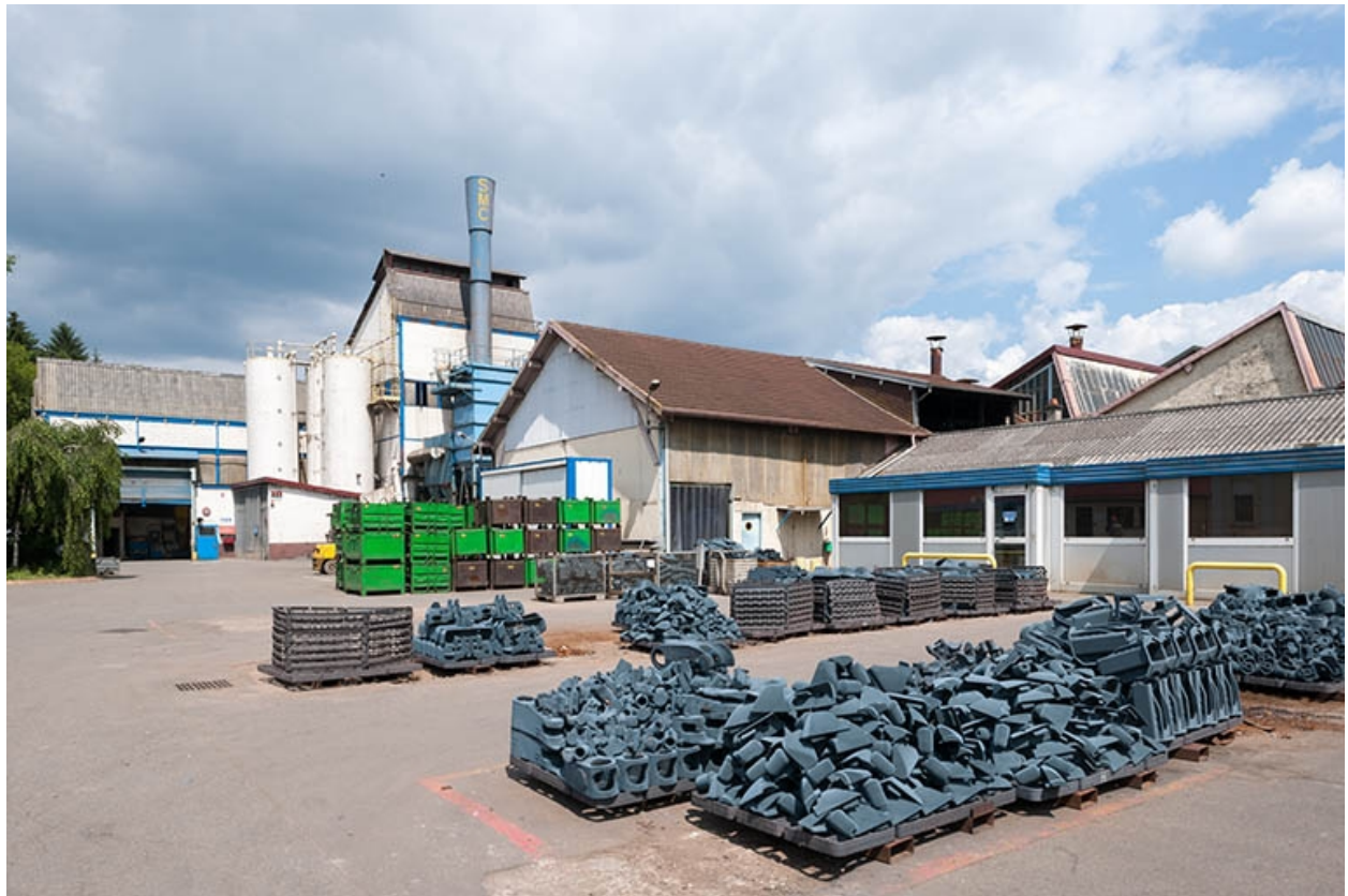
Vue de la cour depuis le sud-ouest.
