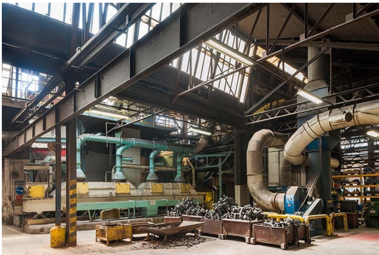
Vue d'ensemble. Ossature métallique.
