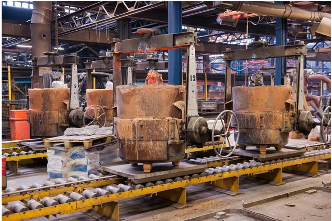
Poches de coulée avant réfection (2).
