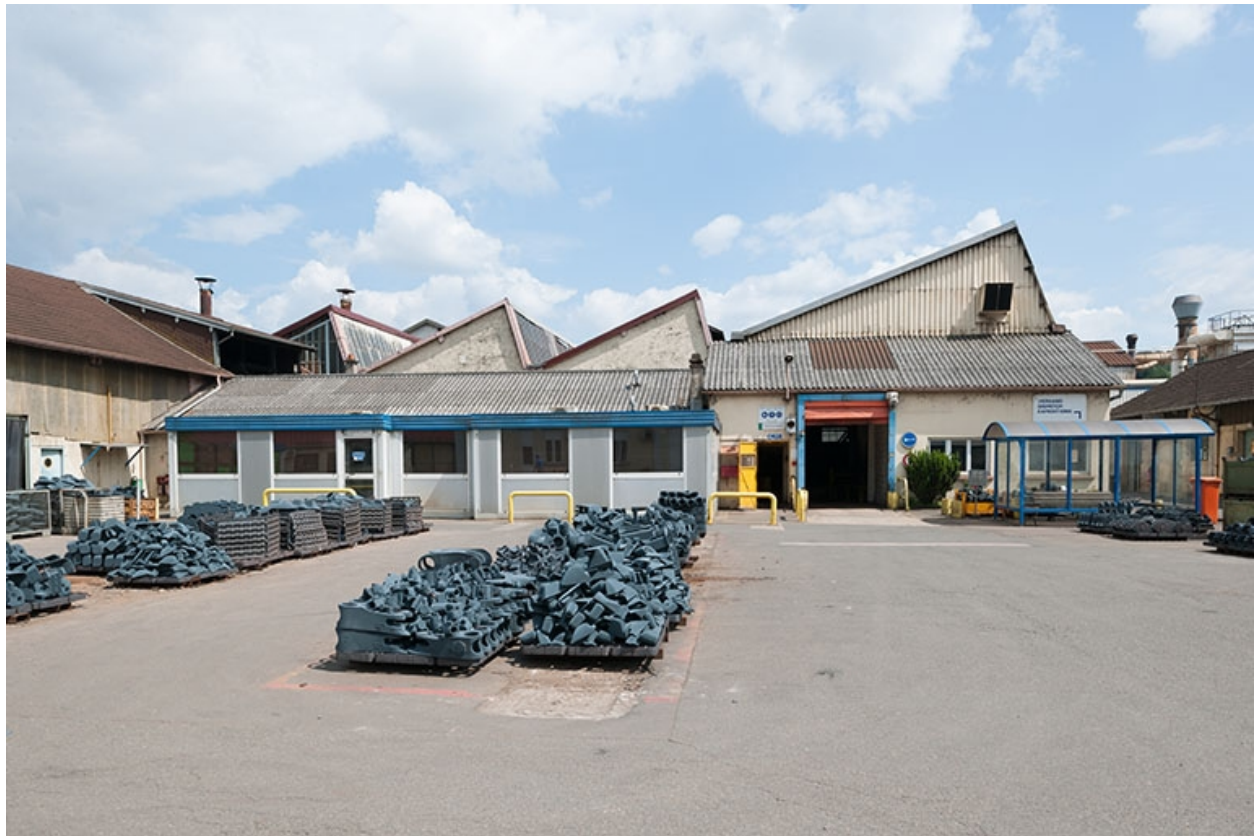
Stockage de pièces moulées dans la cour.
