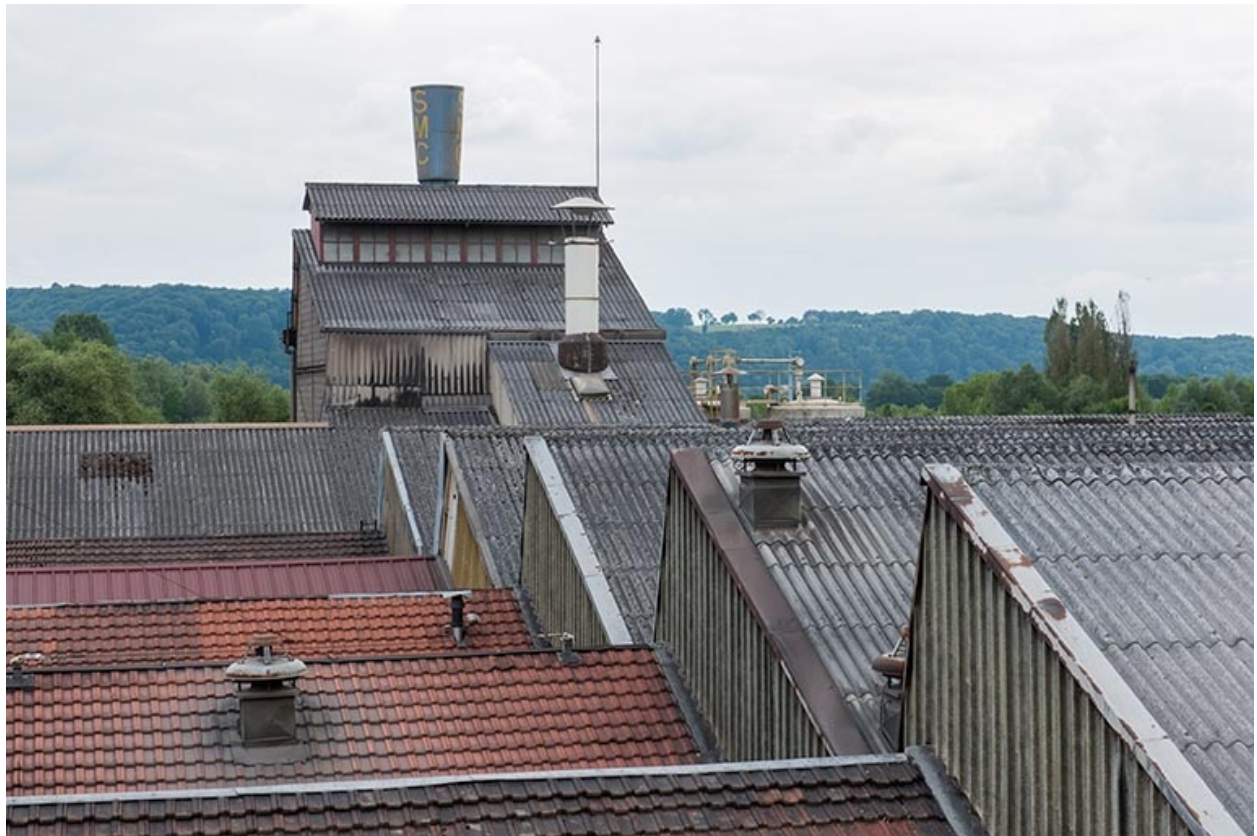
Toitures de l'usine.
