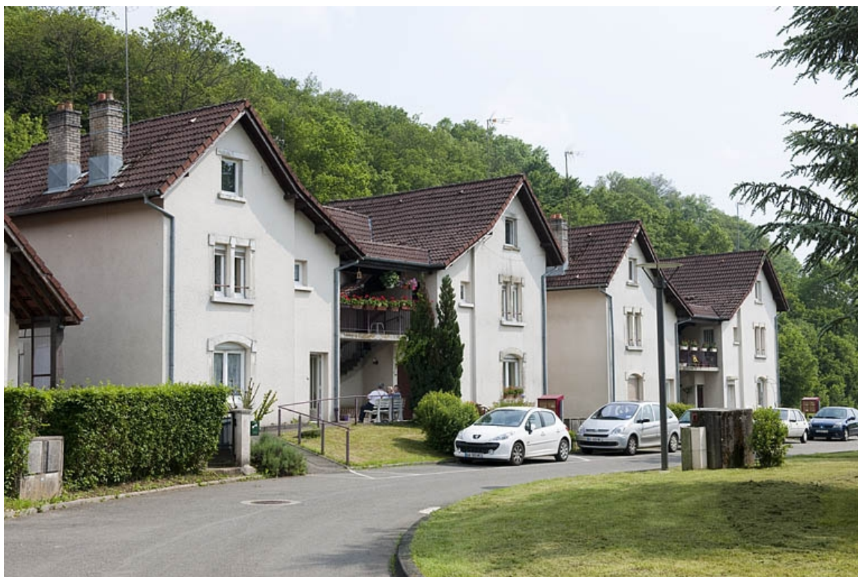
Cité du parc. Habitations de 4 logements.
