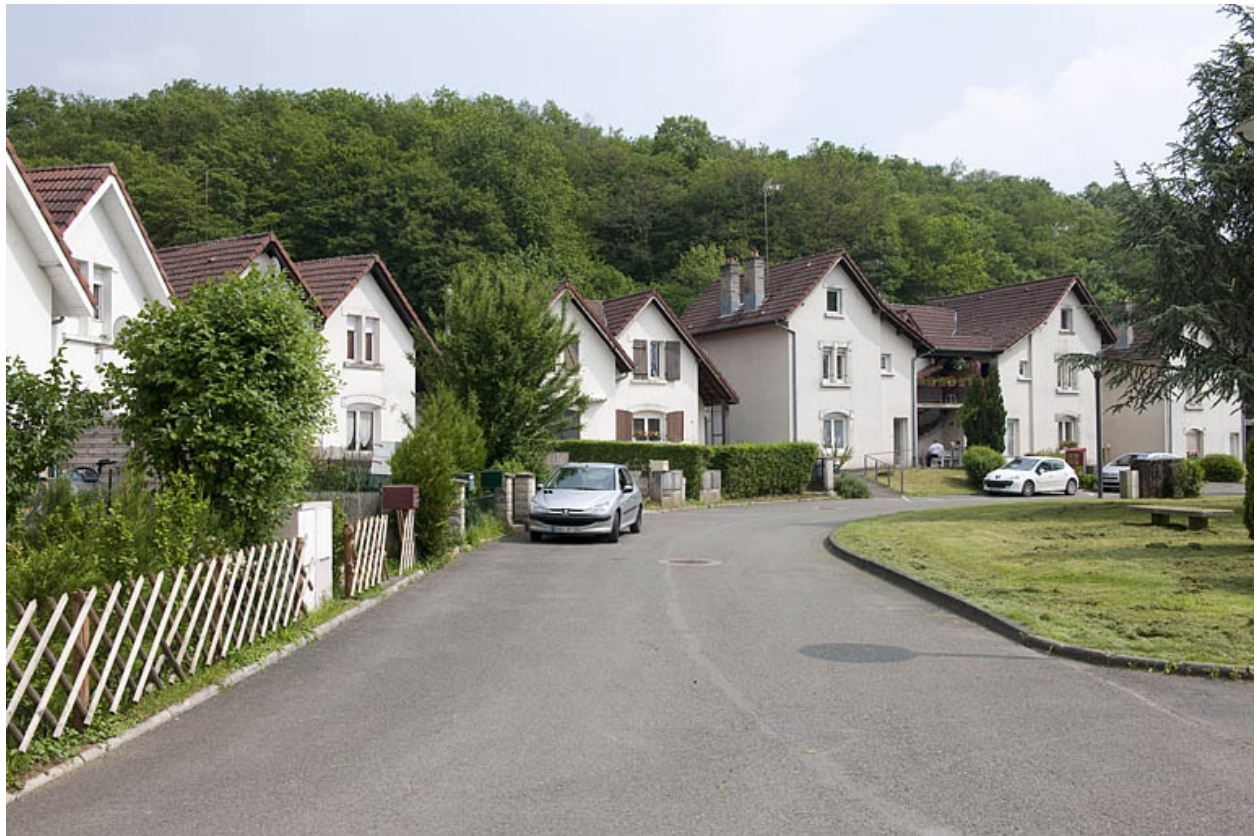
Cité du parc. Vue d'ensemble depuis l'entrée.
