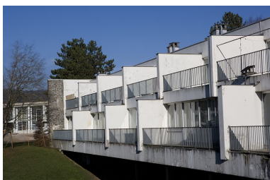
Logements : façades Phot. Yves Sancey
