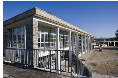
Externat : façades et circulations extérieures. Phot. Yves Sancey IVR43_20063900444NUCA
