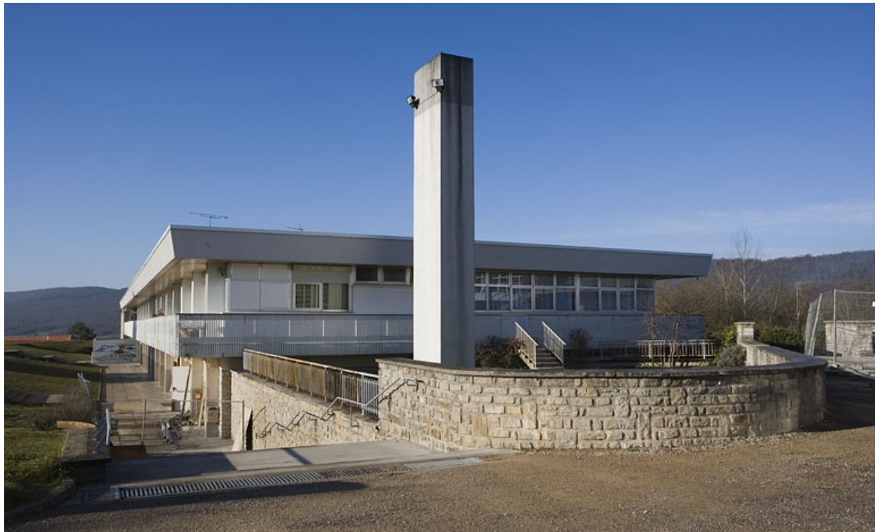
Internat : vue d'un pignon.
