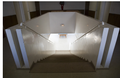
Escalier intérieur : la rampe béton. Phot. Yves Sancey IVR43_20063900431NUCA
