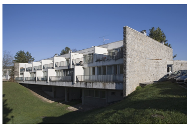
Logements : balcons. Phot. Yves Sancey
