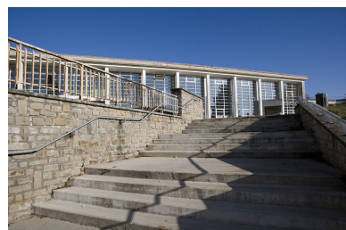
Escalier extérieur. Phot. Yves Sancey IVR43_20063900440NUCA
