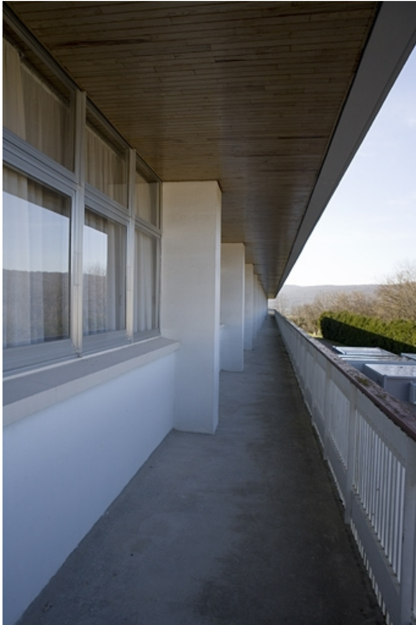
Internat : coursive extérieure à l'étage.
