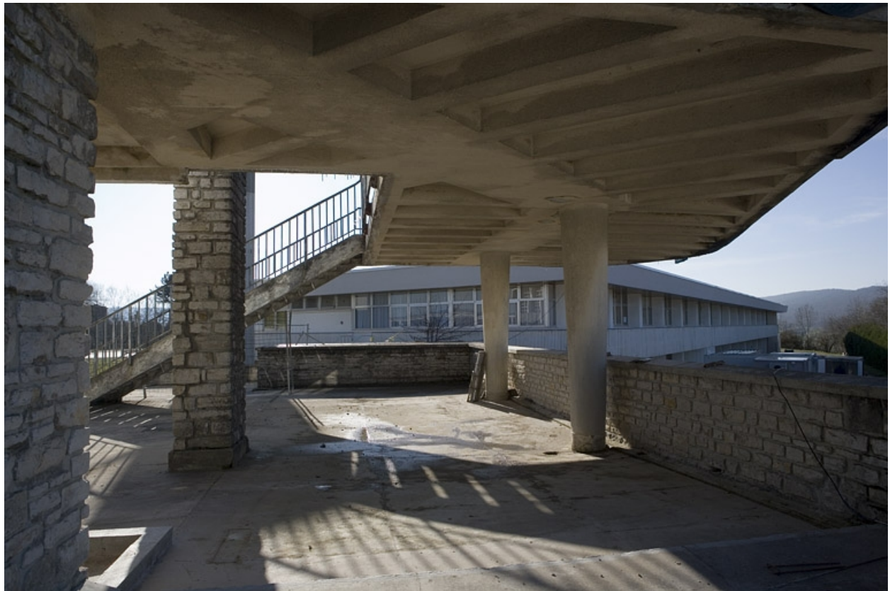
Détails de la mise en oeuvre béton : pilier, coffrage.
