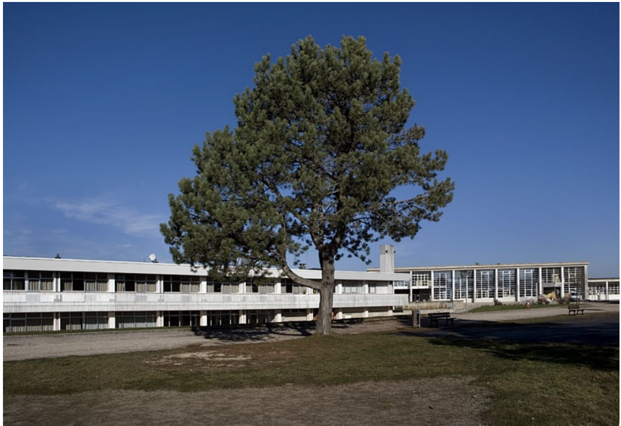
Vue générale des façades des bâtiments d'externat et d'internat.
