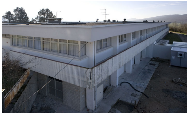
Internat : toit terrasse. Phot. Yves Sancey IVR43_20063900425NUCA
