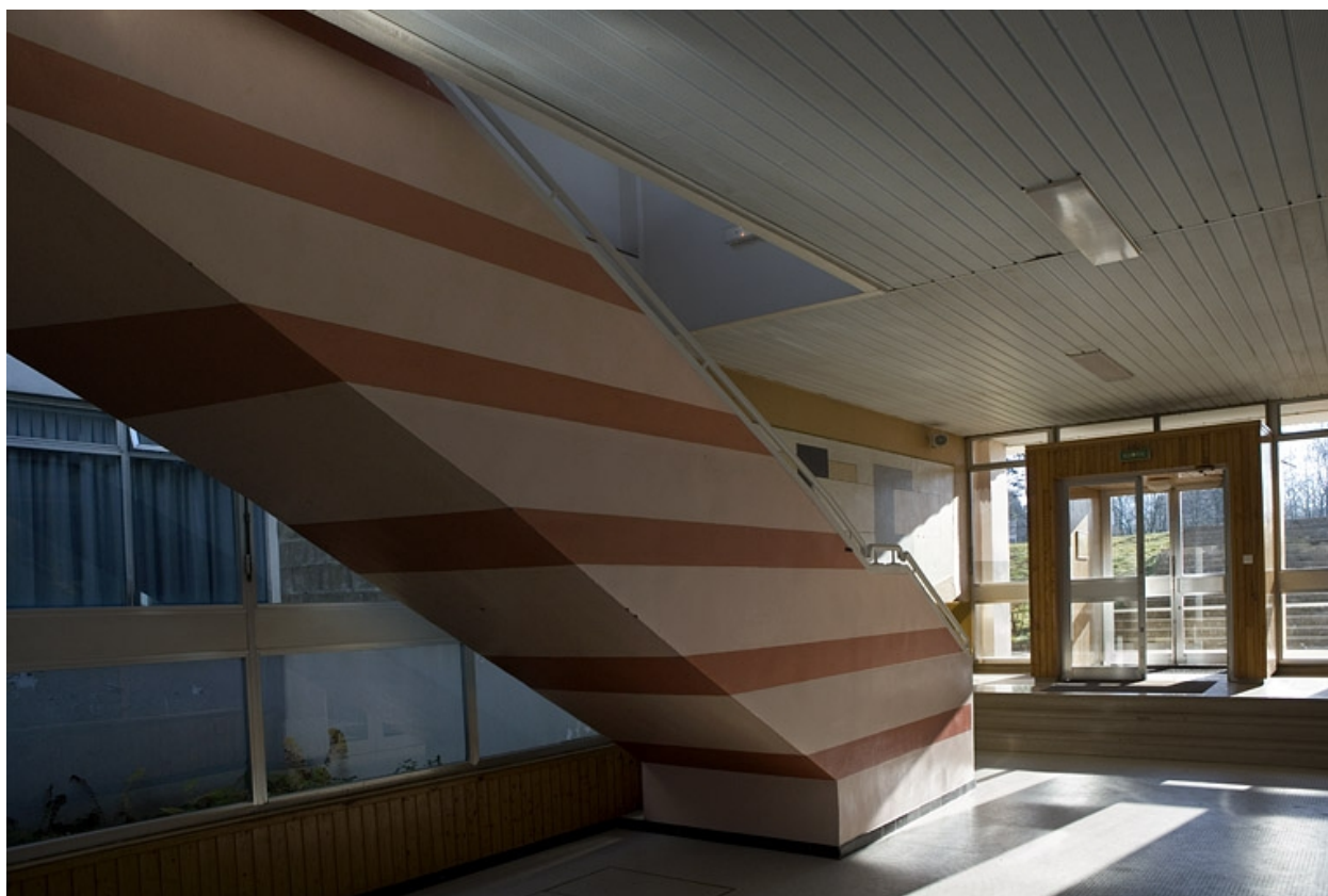
Escalier : traitement graphique du dessous d'escalier.
