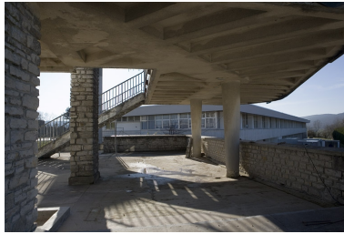
Détails de la mise en œuvre béton : pilier, coffrage. Phot. Yves Sancey IVR43_20063900443NUCA
