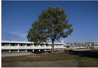
Vue générale des façades des bâtiments d'externat et d'internat. Phot. Yves Sancey IVR43_20063900447NUCA
