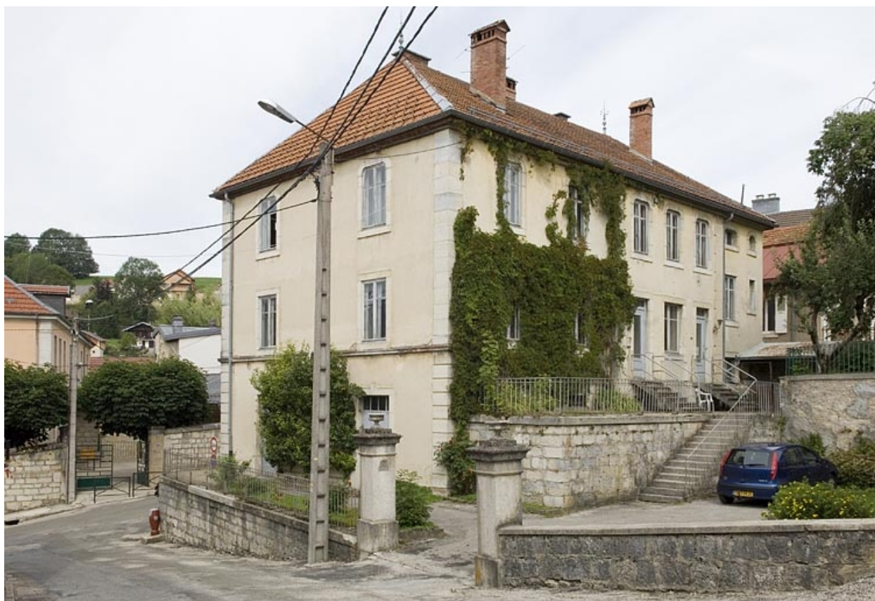
Façades postérieure et latérale droite.
