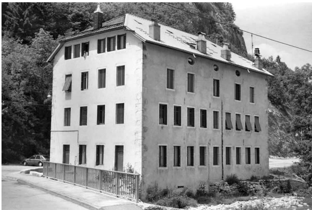
Façades antérieure et latérale droite.
