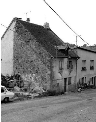
Vue générale. Phot. Yves Sancey IVR43_19843900385X
