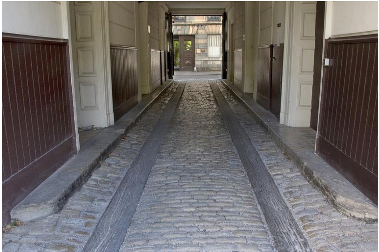
Vue d'ensemble du passage cocher depuis l'entrée.
