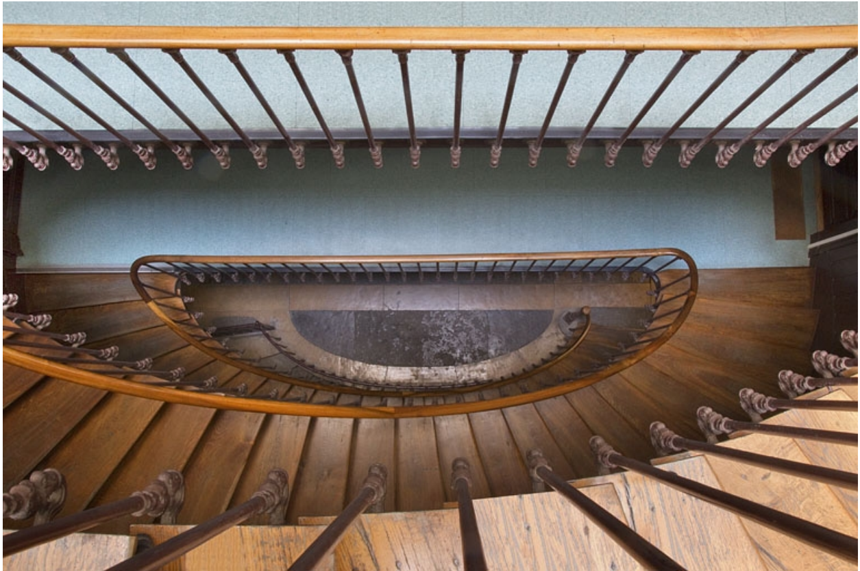
Intérieur, escalier : vue plongeante.
