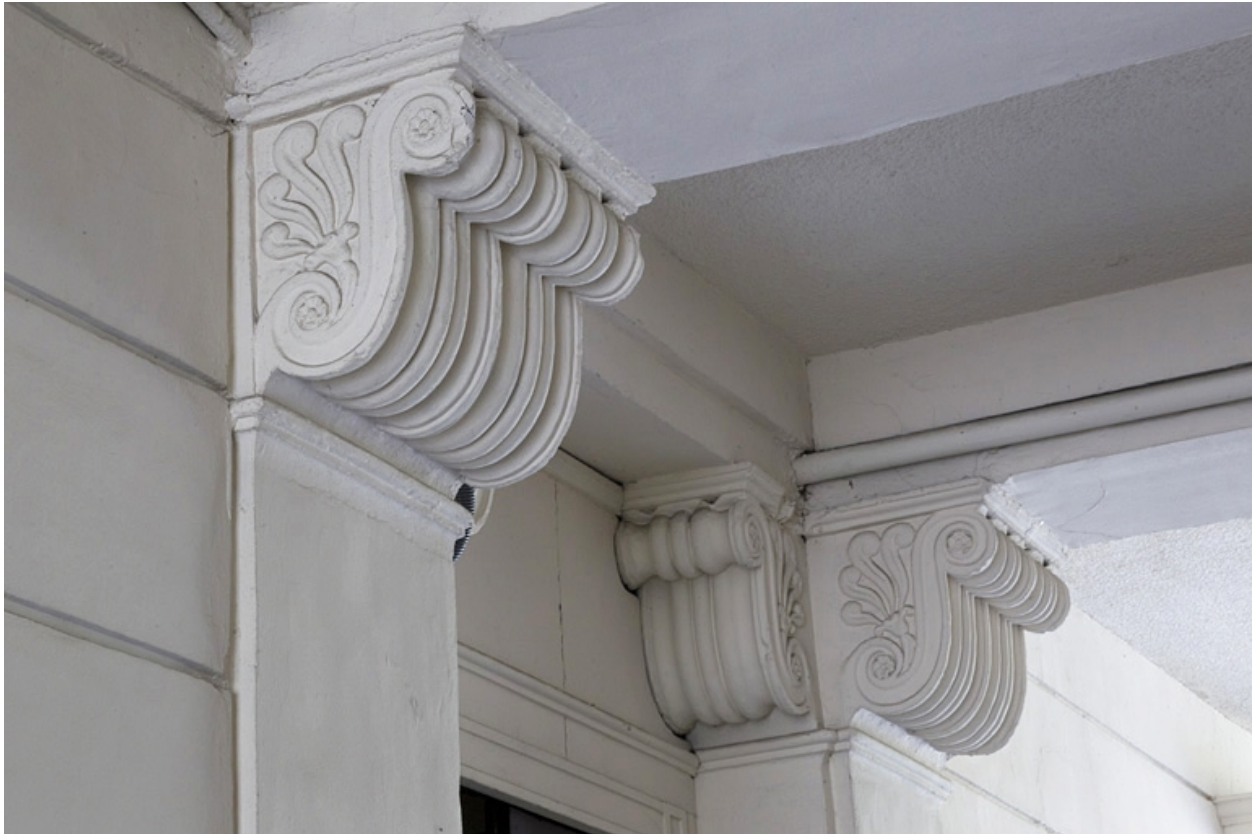
Passage cocher : détail d'une console.
