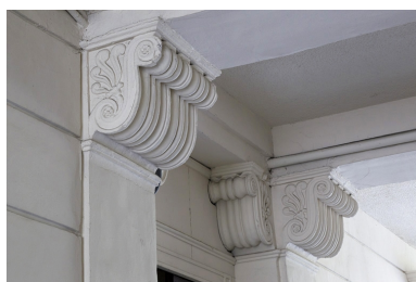
Passage cocher : détail d'une console.
