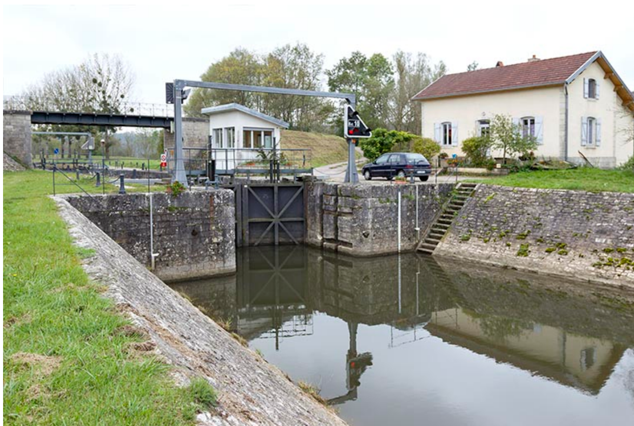
Vue aval de l'entrée du sas.
