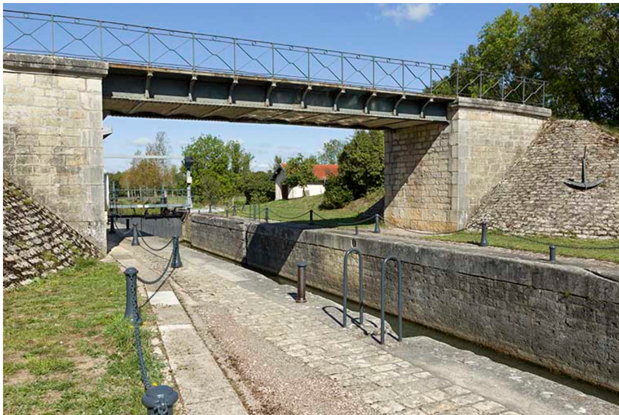
Le pont métallique au dessus de l'écluse.
