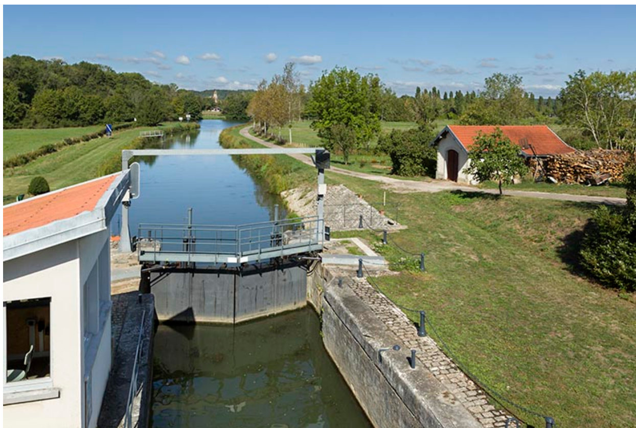
Vue de l'écluse depuis la passerelle métallique.
