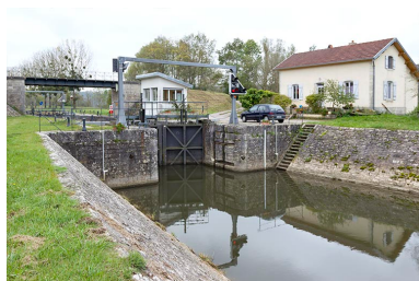
Vue aval de l'entrée du sas. Phot. Sonia Dourlot
