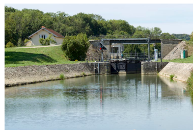
Entrée amont de l'écluse à sas. Phot. Sonia Dourlot IVR43_20157000812NUC2A
