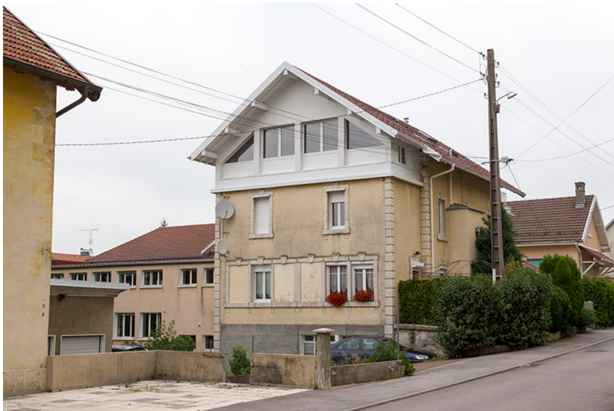
Maison : façades antérieure et latérale gauche.
