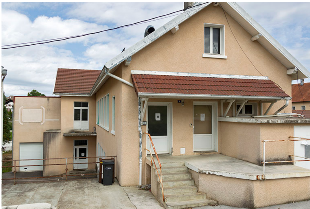
Usine : façade antérieure.
