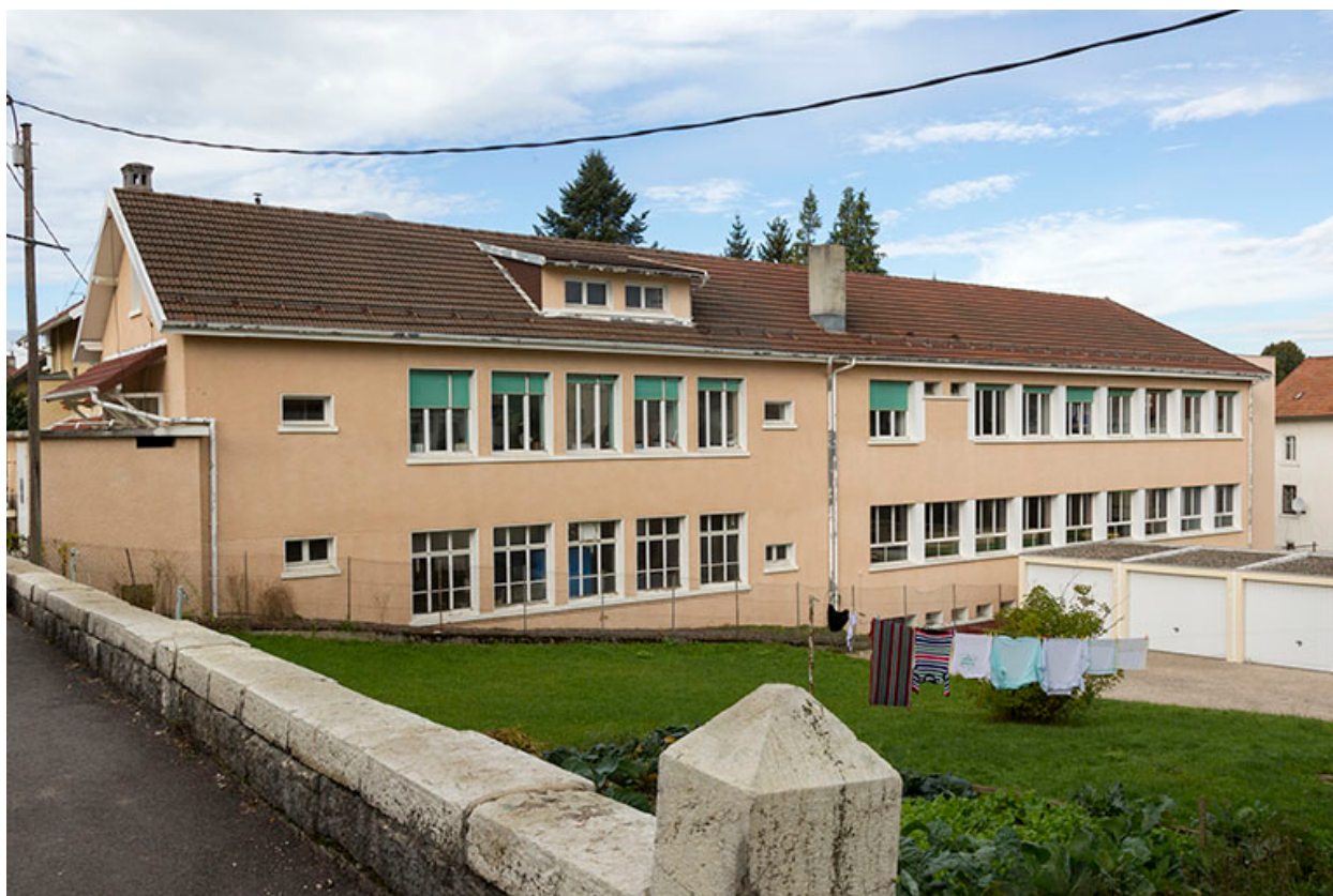
Usine : façade latérale droite, depuis la Rue Neuve.
