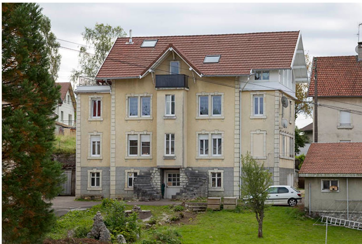
Maison : façade postérieure.
