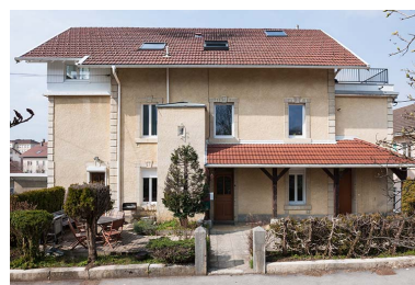
Maison : façade antérieure. Phot. Jérôme Mongreville IVR43_20142500168NUC4A
