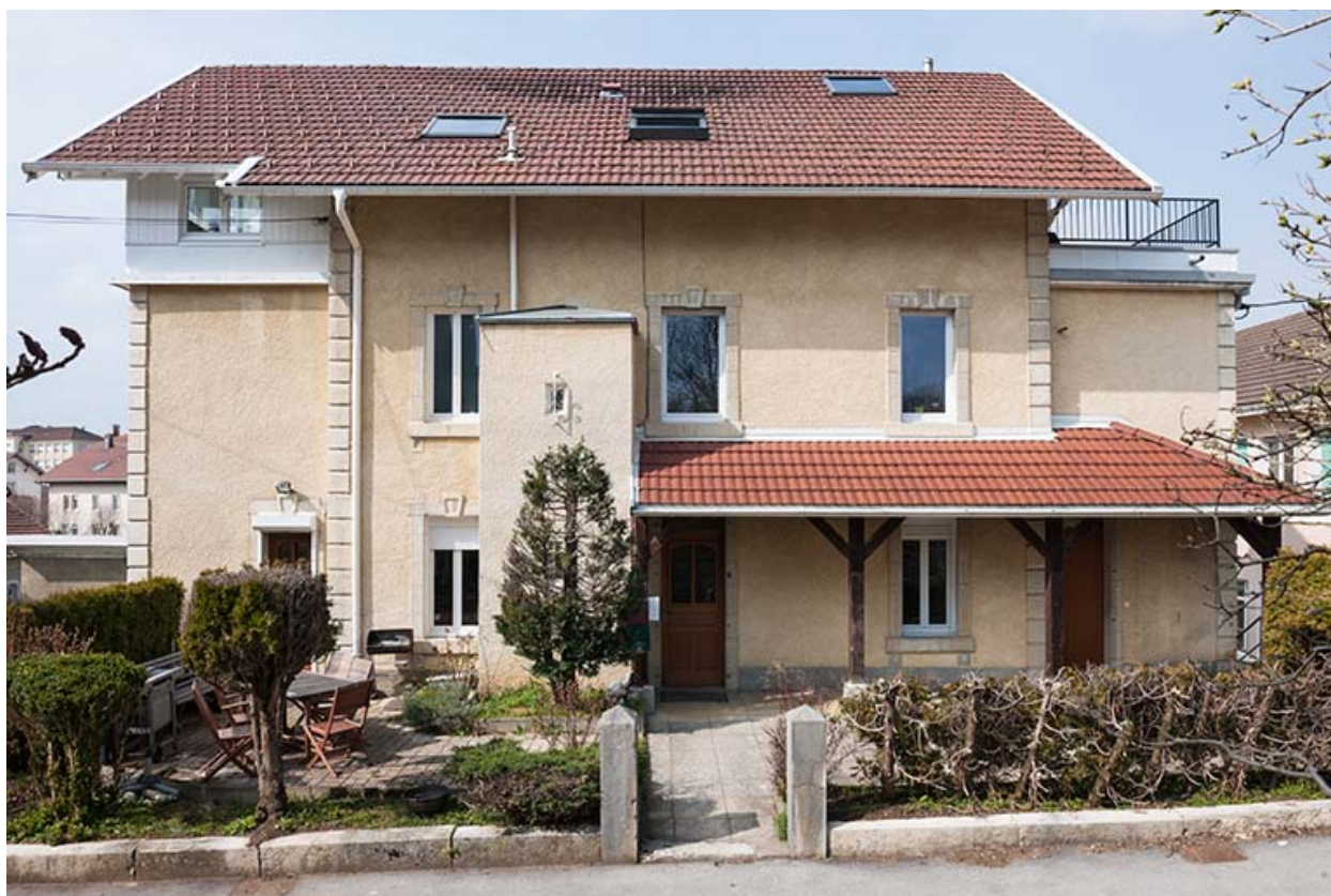
Maison : façade antérieure.
