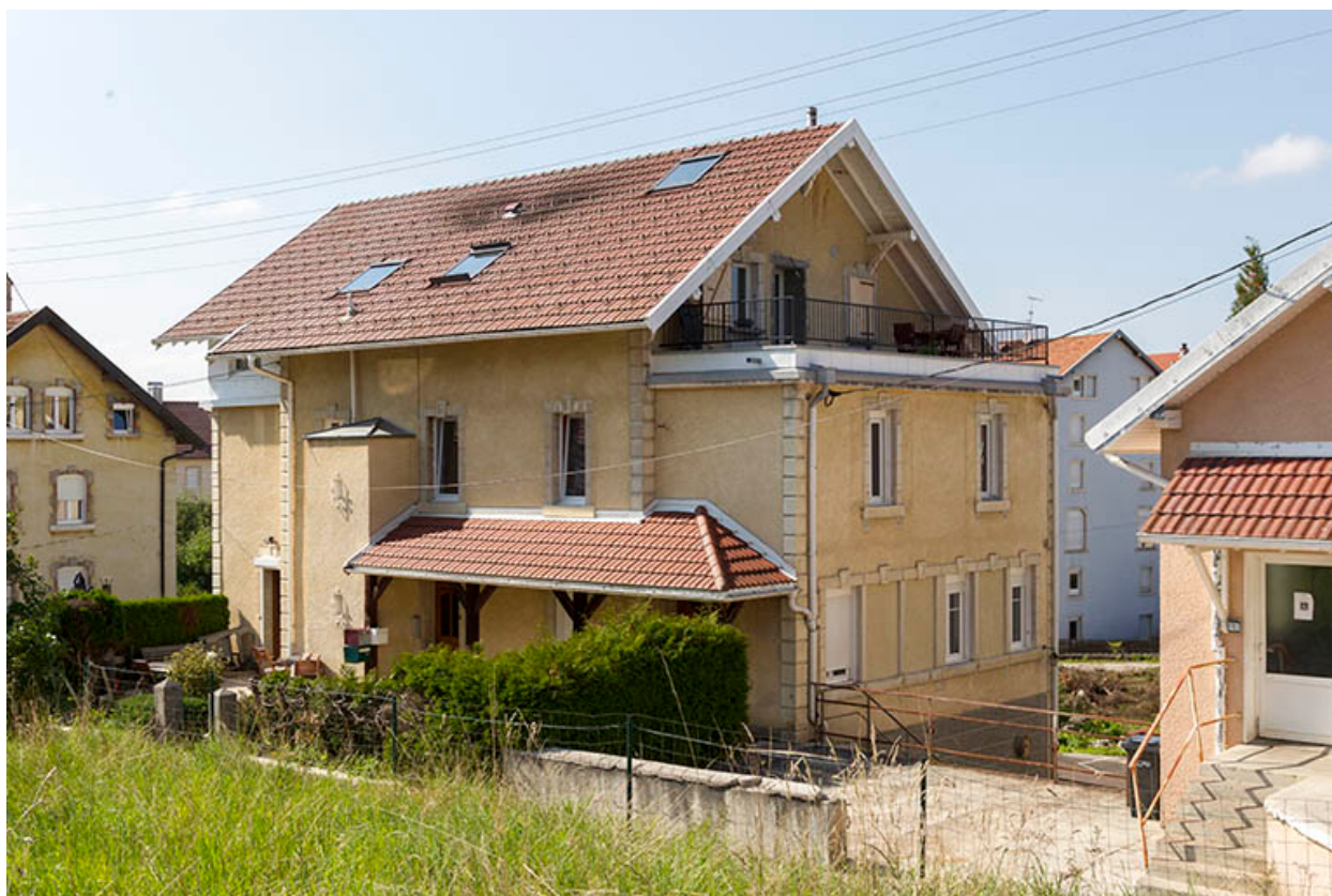
Maison : façades antérieure et latérale droite.
