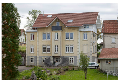
Maison : façade postérieure. Phot. Sonia Dourlot IVR43_20142501876NUC2A
