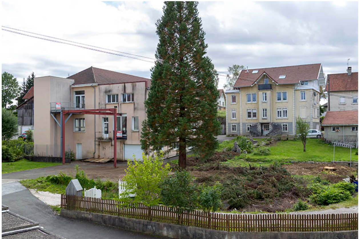
Vue d'ensemble, depuis le nord (façades postérieures).
