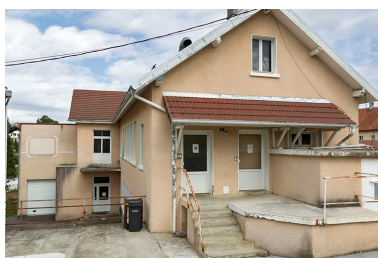
Usine : façade antérieure. Phot. Sonia Dourlot IVR43_20142501874NUC2A
