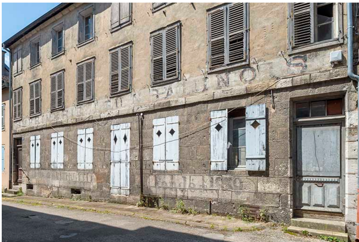
Façade postérieure (rue d'Orgemont). Partie inférieure.
