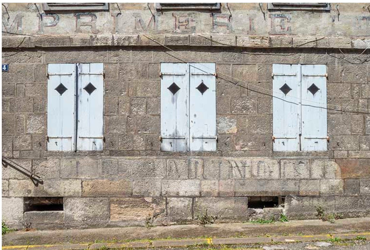
Façade rue d'Orgemont. Rez-de-chaussée des travées sud.
