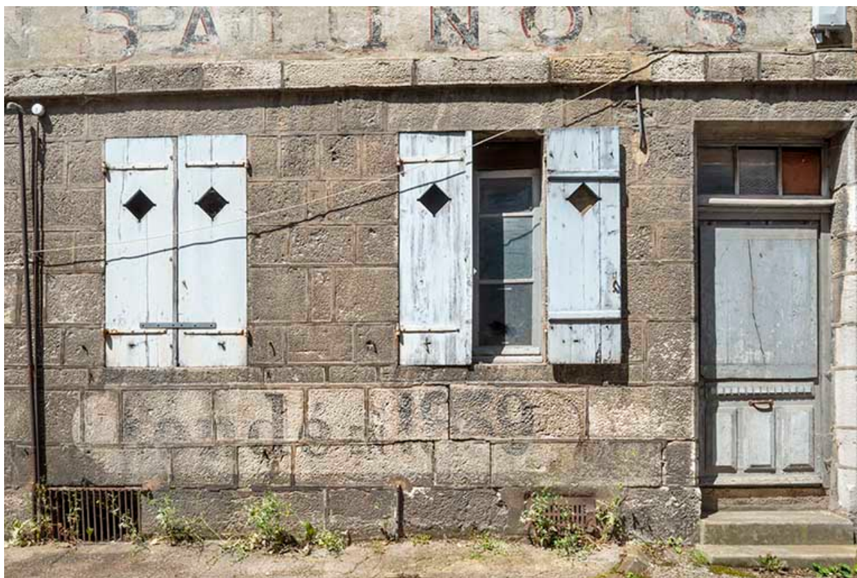
Façade rue d'Orgemont. Rez-de-chaussée des travées nord.
