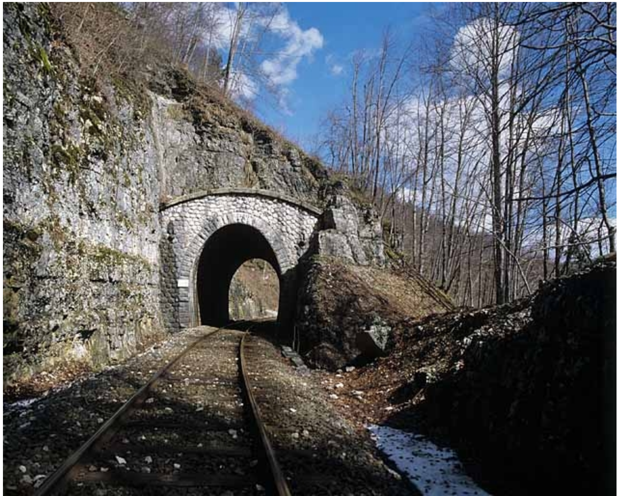
Vue d'ensemble, côté La Cluse (sud).
