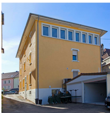
Un immeuble construit par Loeffler vers 1932, avec atelier de décolletage au dernier étage, au 13 rue du Général de Gaulle (façade postérieure).
