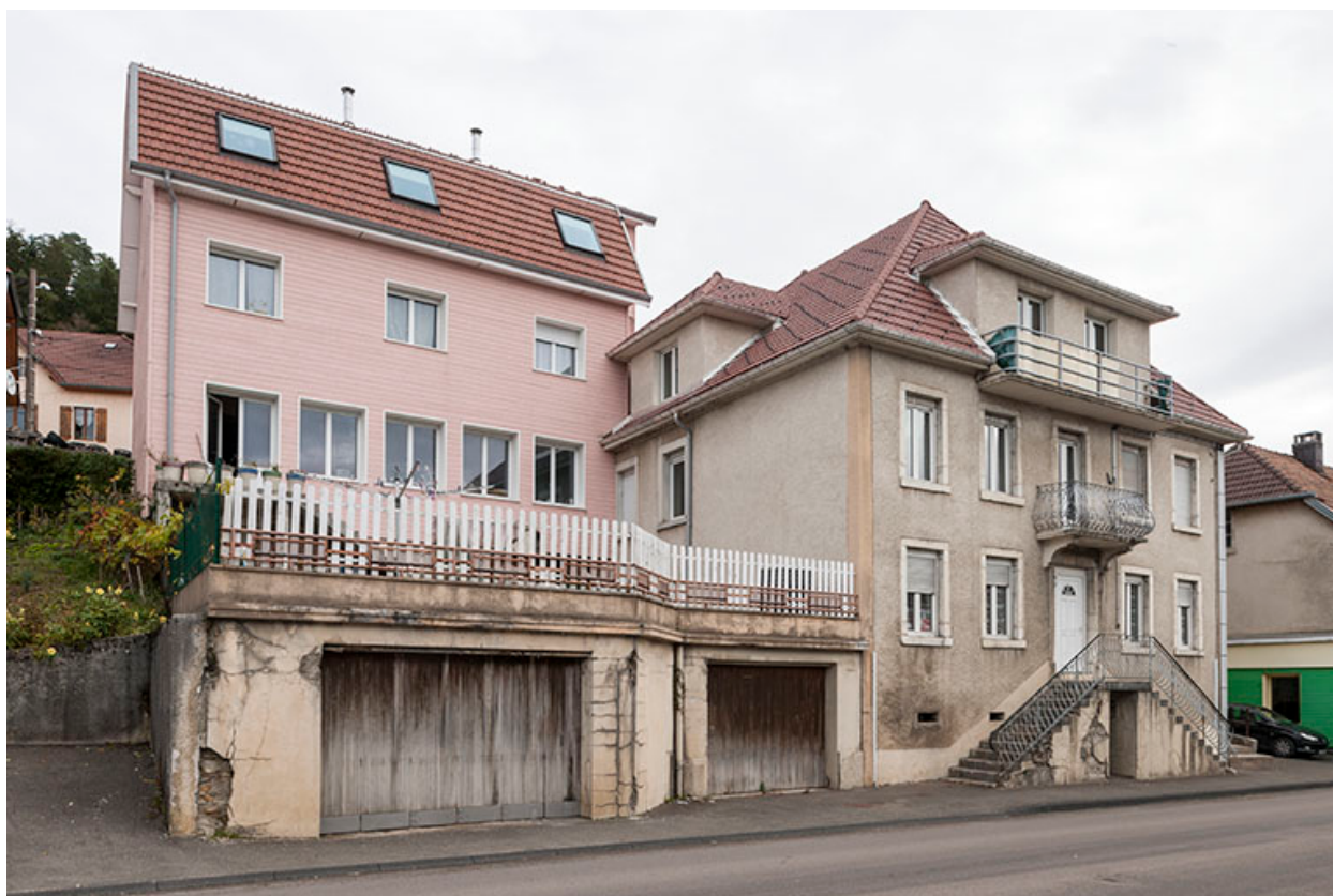
Un bâtiment horloger ancien : l'atelier Vauthier et Monnot (1878) au 12 rue de Saint-Hippolyte, agrandi par Triponney (vers 1925-1931).
