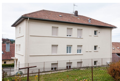
Le site en expansion d'un fabricant de machines pour les horlogers : l'entreprise Maïre et Perrier construit son usine en 1953 (façade postérieure).
