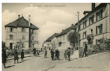
Réutilisation d'un bâtiment existant (1866) : la fabrique d'échappements
