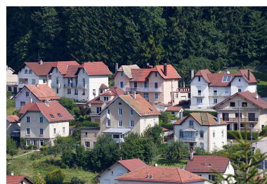
Une grosse entreprise : la société Rotschi et ses cités ouvrières. Cité de Montjoie (décennie 1910), 1, 3-7 rue de Montjoie. Phot. Yves Sancey IVR43_20132501903NUC2A
