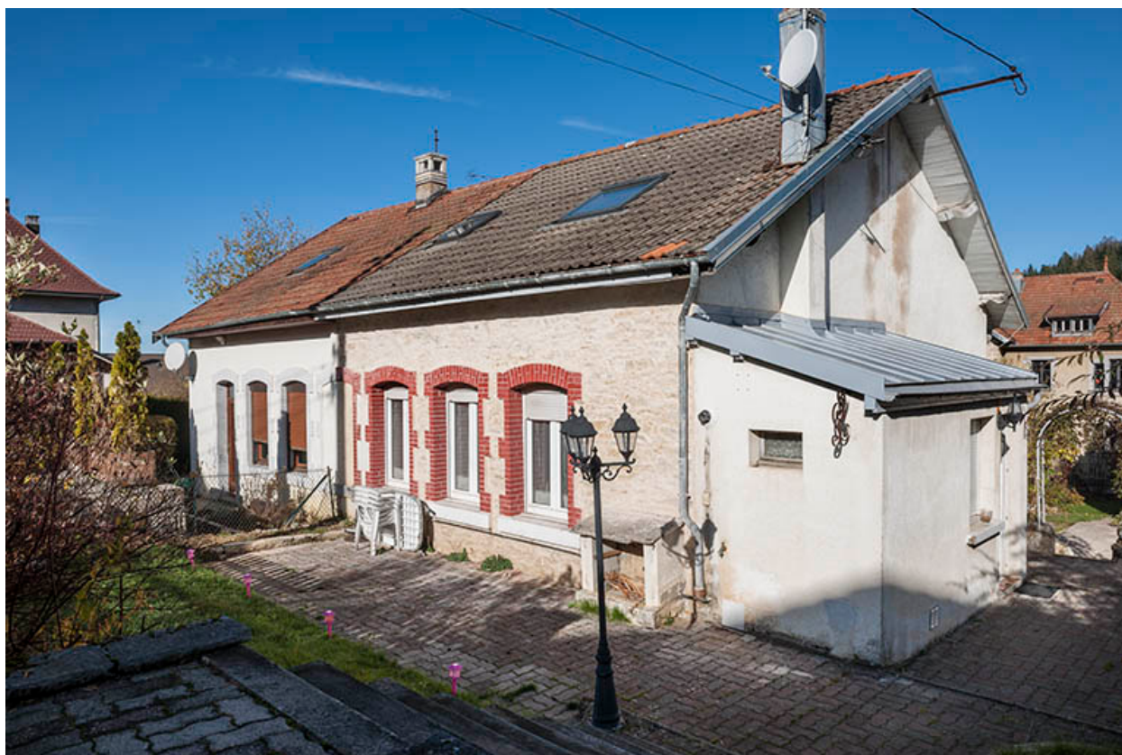
Une petite entreprise familiale du début du 20e siècle, rue de l'Helvétie : la société Tissot et son atelier de fabrication d'assortiments à cylindre (façade postérieure).
