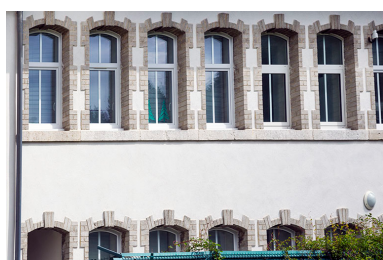
Les Mauvais, une famille d'horlogers entrepreneurs : l'usine Mauvais Frères et Rondot (1901-1902), rue Guynemer (fenêtres à encadrement en briques grises). Phot. Yves Sancey IVR43_20132501968NUC2A
