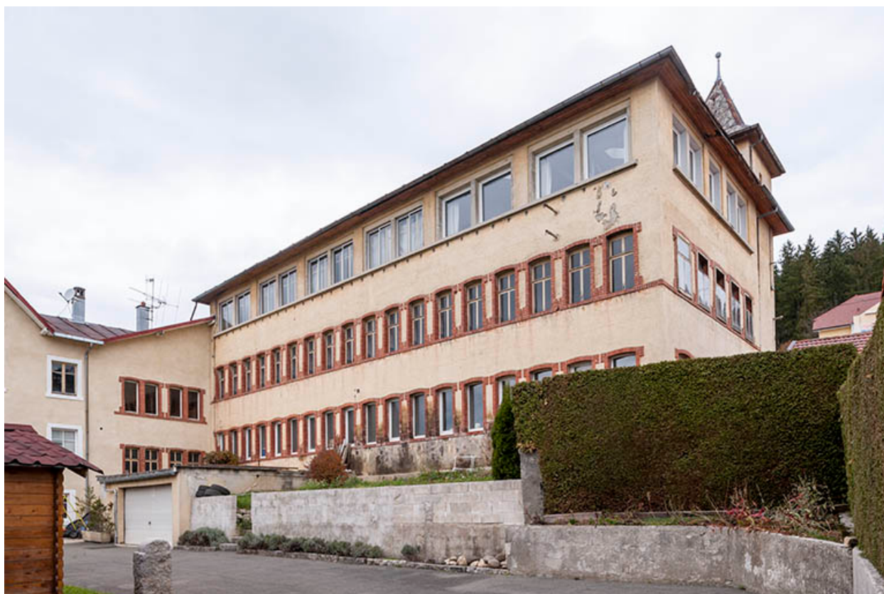
Une grosse entreprise : la société Rotschi et son usine d'échappements à cylindre (1899-1906), aux 7 et 9 rue du Mont.
