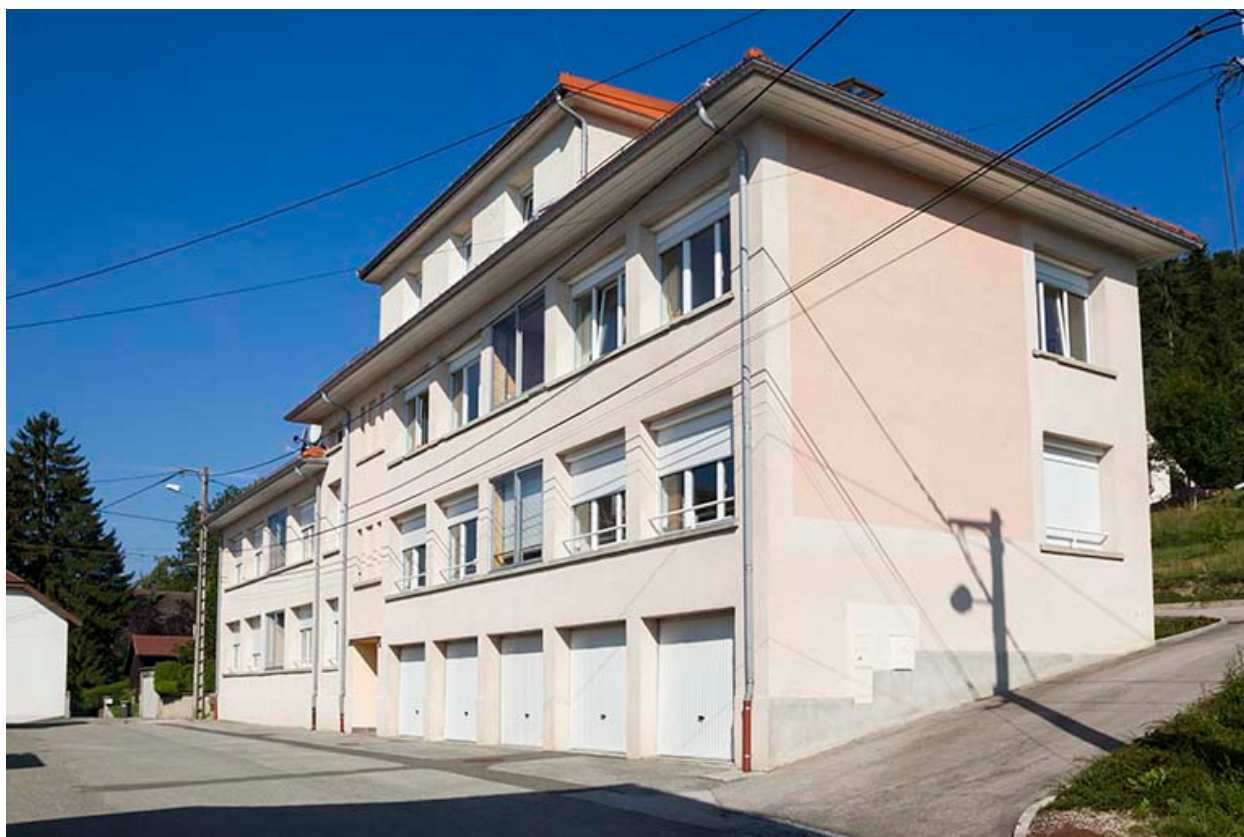
Une usine importante de l'après-guerre : l'usine de fournitures pour l'horlogerie et de montres Paul Poupeney et Fils (1952), au 7 rue Paul Monnot.
