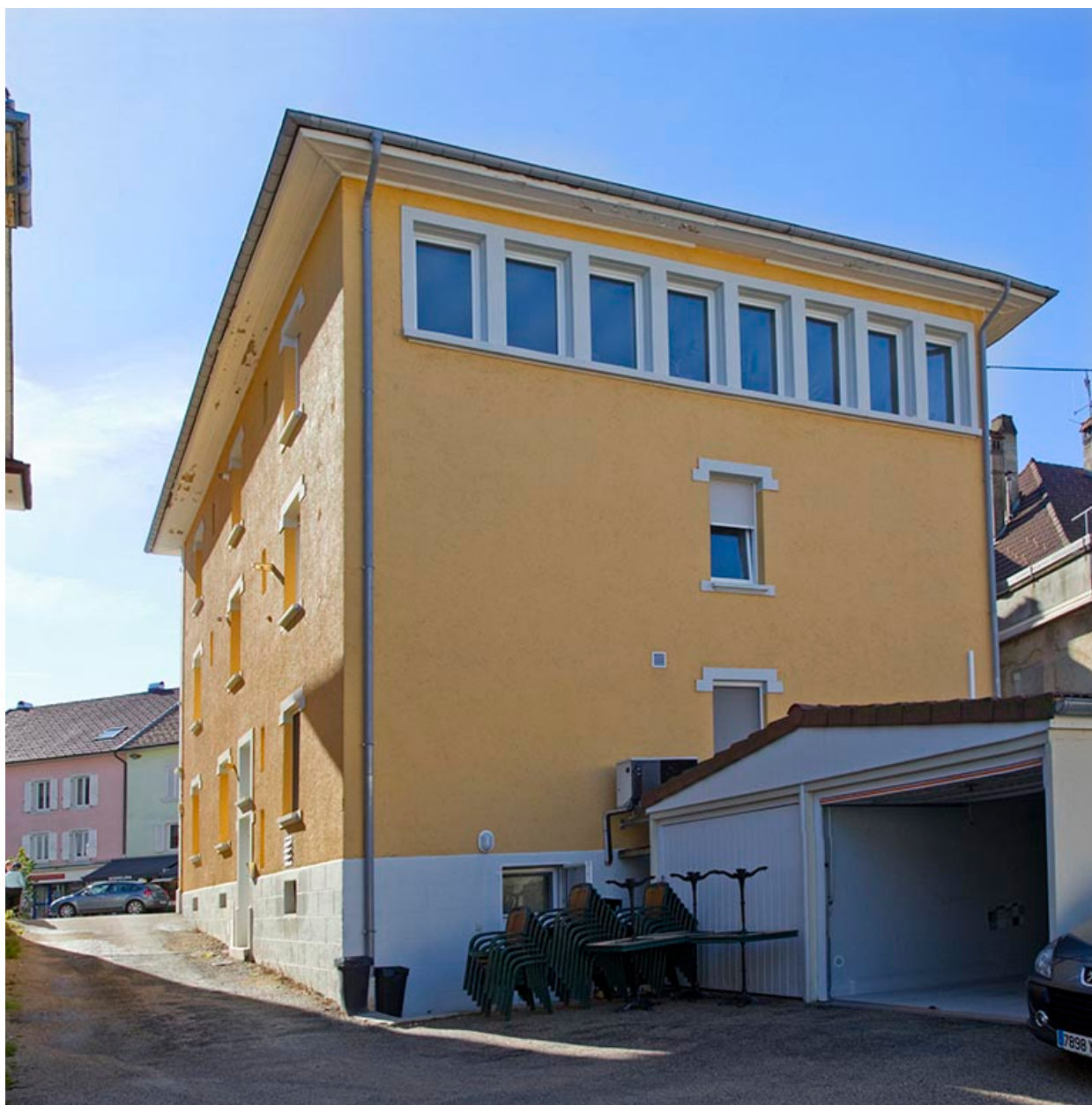
Un immeuble construit par Loeffler vers 1932, avec atelier de décolletage au dernier étage, au 13 rue du Général de Gaulle (façade postérieure).
