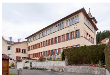
Une grosse entreprise : la société Rotschi et son usine d'échappements à cylindre (1899-1906), aux 7 et 9 rue du Mont. Phot. Jérôme Mongreville IVR43_20152502160NUC4A
