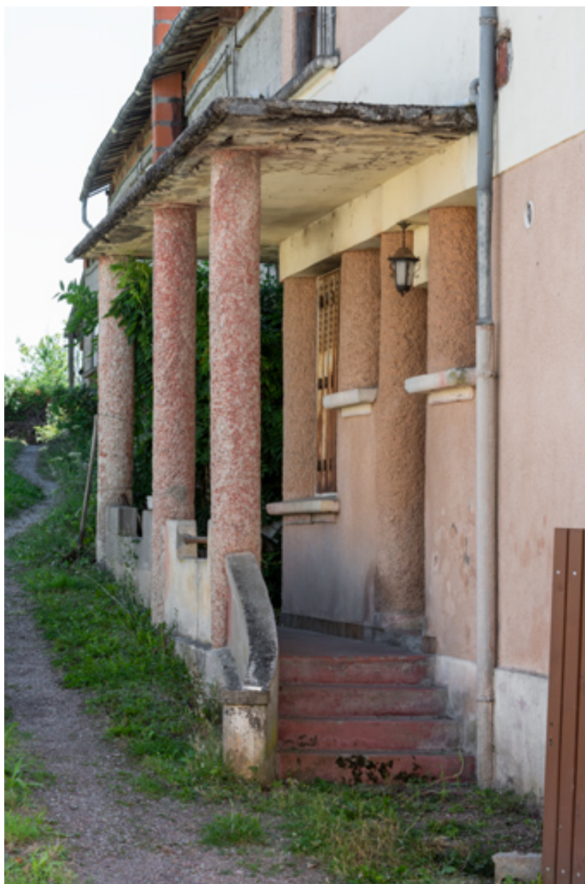
Façade latérale gauche : escalier couvert.
