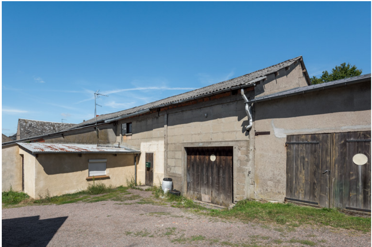
Façades latérale droite et postérieure (la salle).
