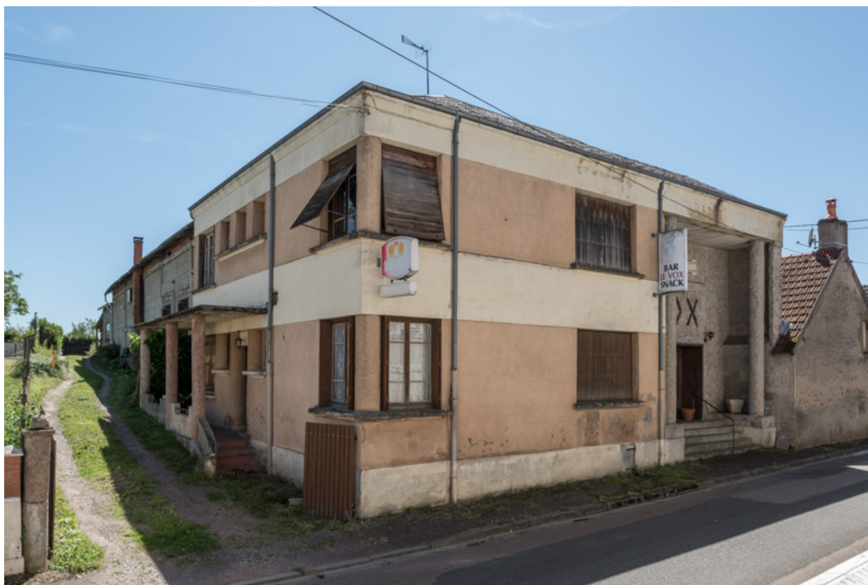
Façades antérieure et latérale gauche.
