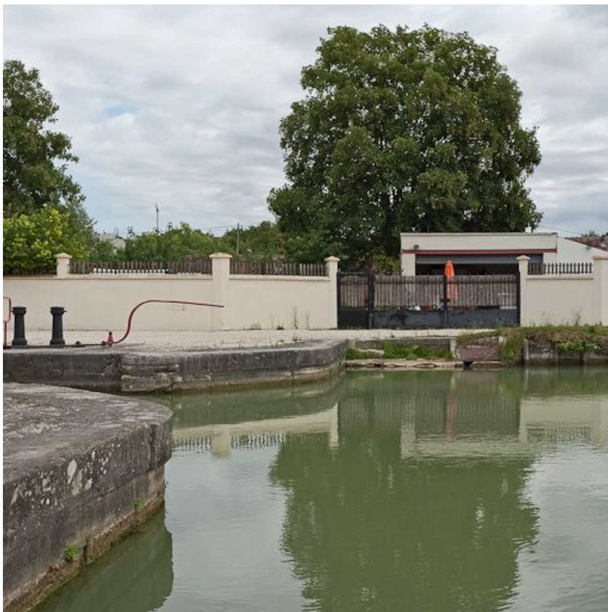
Vue du lavoir de la maison.
