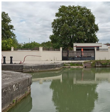
Vue du lavoir de la maison.
