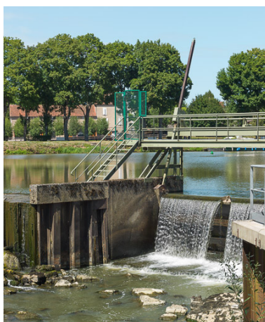
Vue du déversoir. Phot. Pierre-Marie Barbe-Richaud IVR26_20175800200NUC2A
