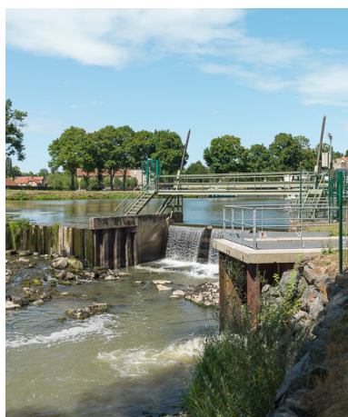
Vue du barrage. Phot. Pierre-Marie Barbe-Richaud IVR26_20175800199NUC2A
