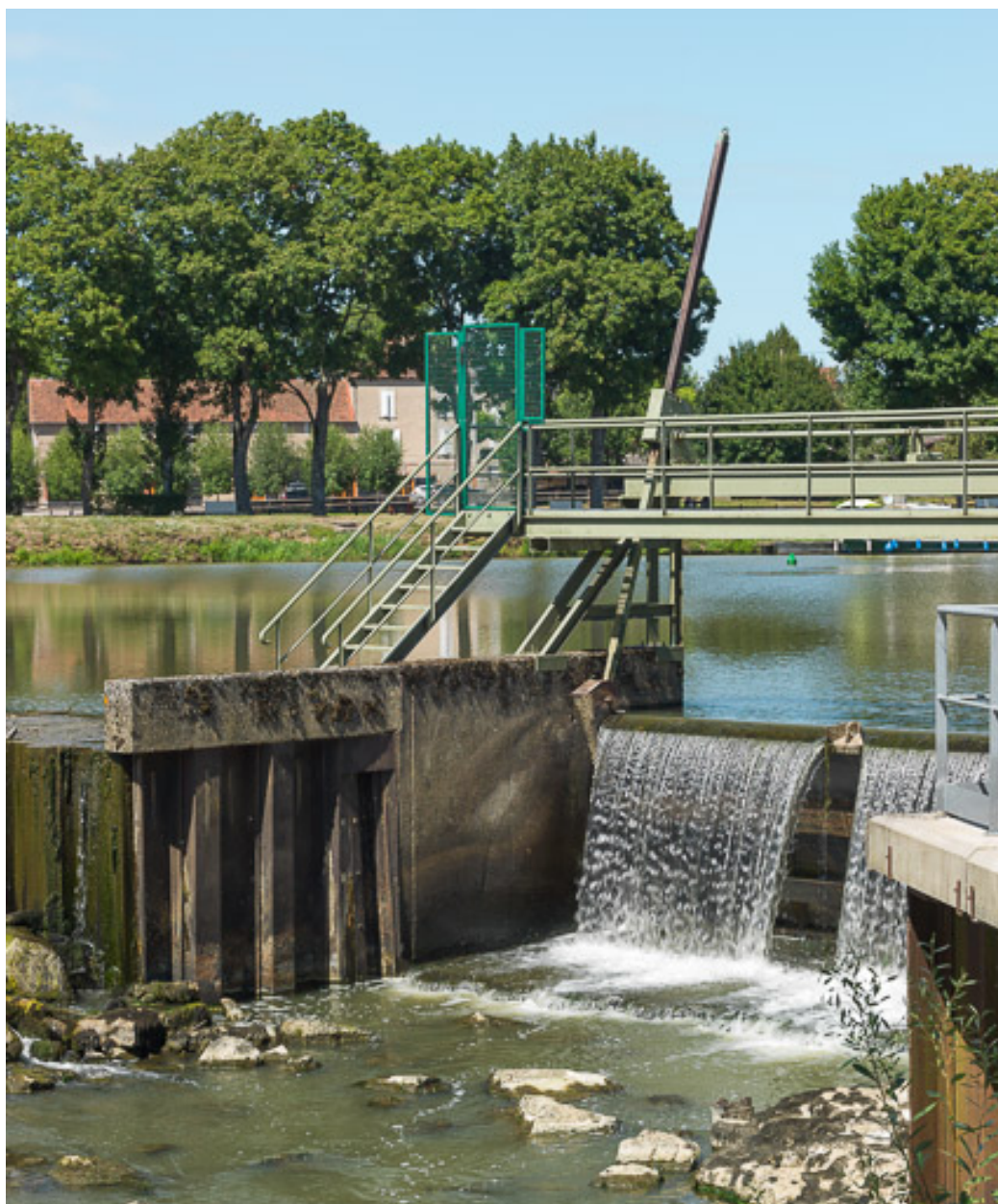
Vue du déversoir.
