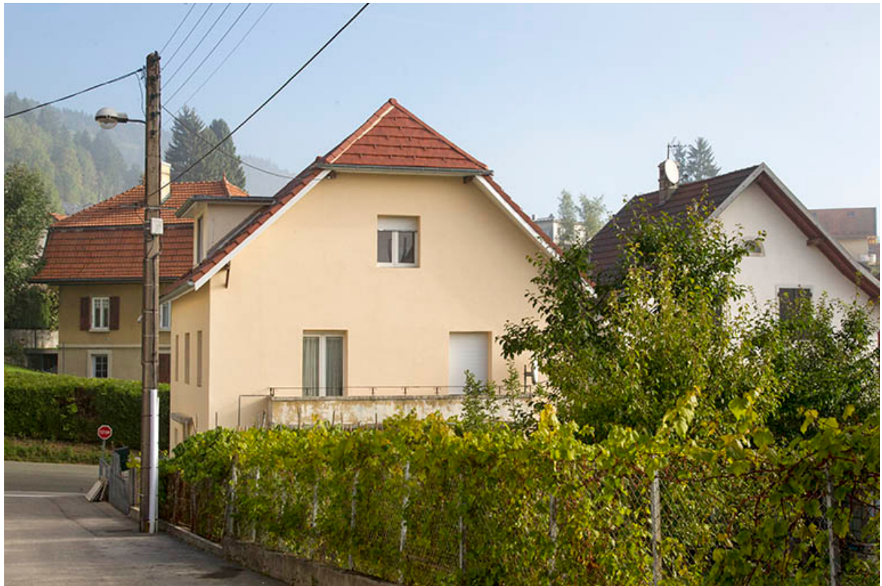
Façade latérale droite.
