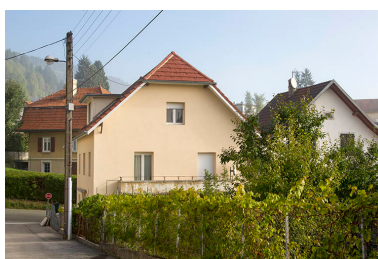
Façade latérale droite. Phot. Yves Sancey IVR43_20132502341NUC2A
