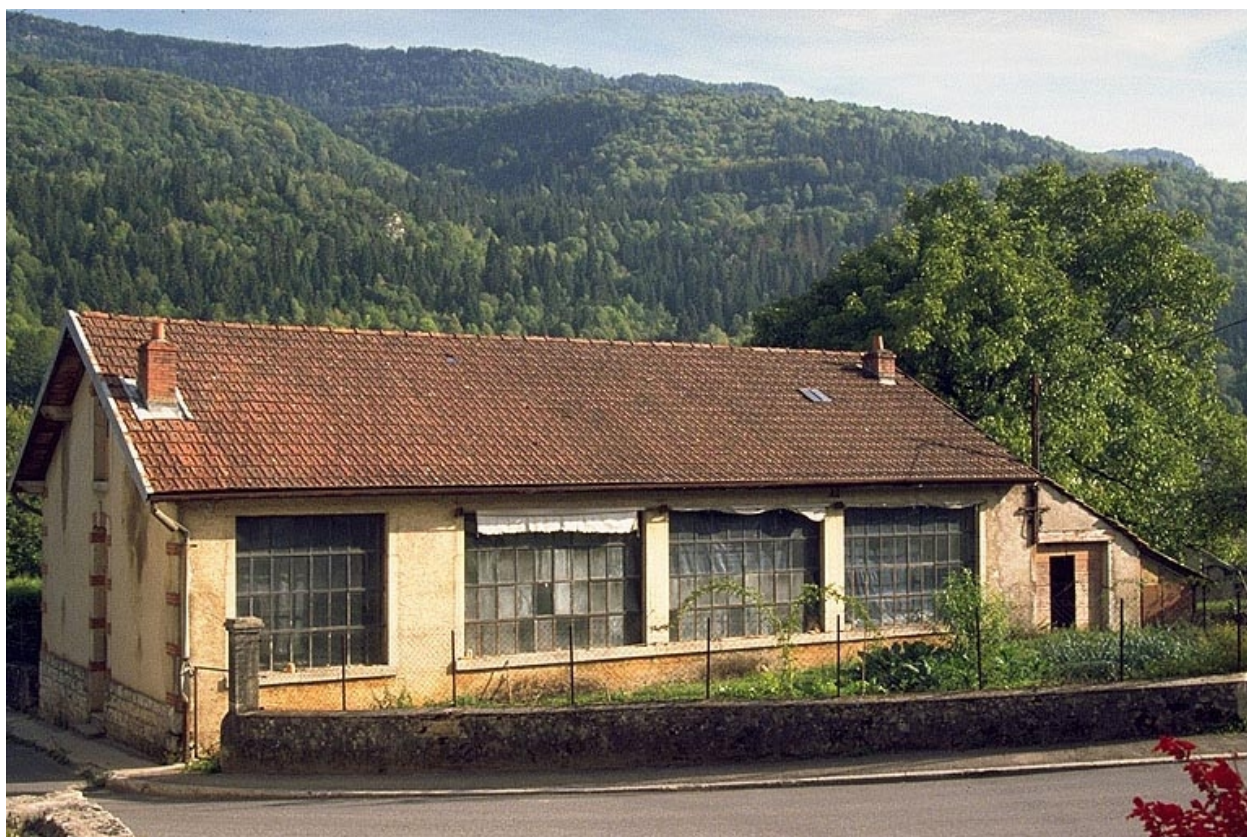
Façade latérale droite de l'atelier de fabrication.
