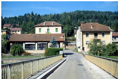
Vue d'ensemble depuis le pont. Phot. Laurent Poupard IVR43_19903900567ZA
