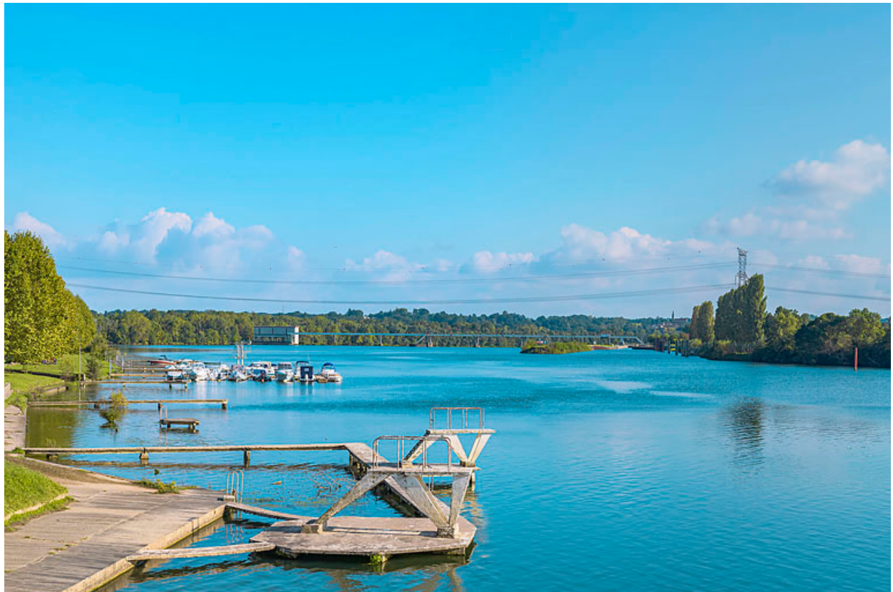
Le barrage de Dracé vu depuis Thoissey.
