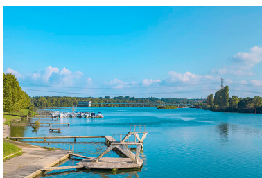
Le barrage de Dracé vu depuis Thoisse. Phot. Thierry Kuntz IVR84_20210100452NUC4A
