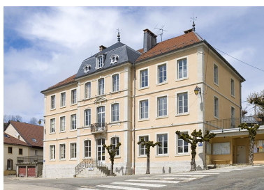
Jougne (Doubs) : mairie-école Phot. Jérôme Mongreville IVR43_20092500495NUC2A
