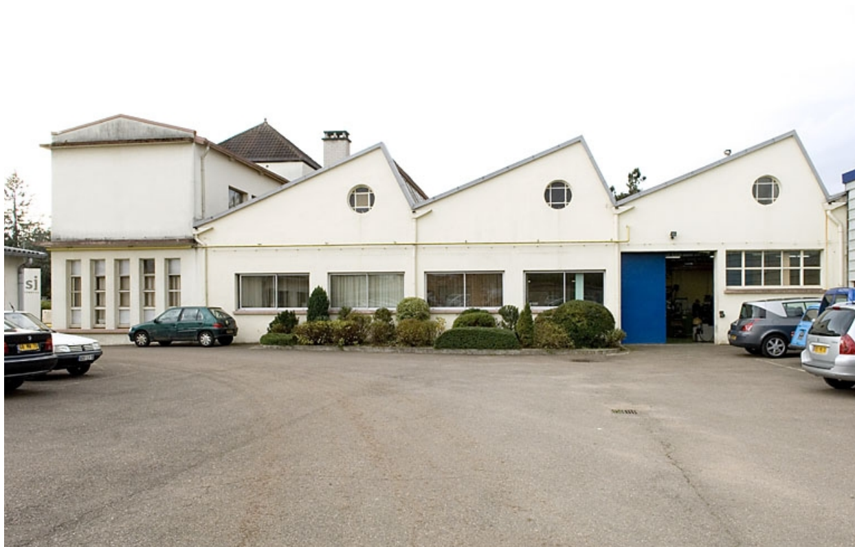
Murs-pignons de l'atelier de fabrication.
