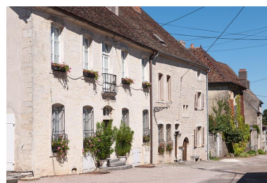
Rue du Bourg, vue depuis l'ouest Phot. Jérôme Mongreville IVR43_20137000203NUCA
