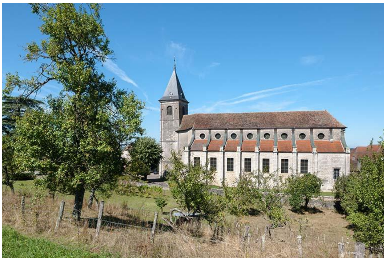
Vue générale sud de l'église
