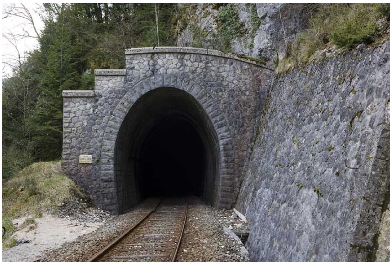
Tunnel : tête côté Andelot-en-Montagne (nord).
