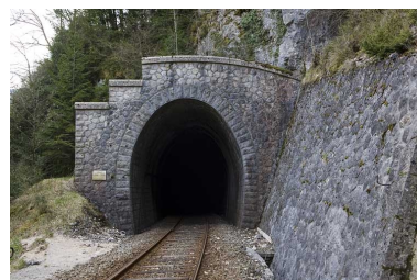
Tunnel : tête côté Andelot- en-Montagne (nord). Phot. Yves Sancey IVR43_20073900173NUCA
