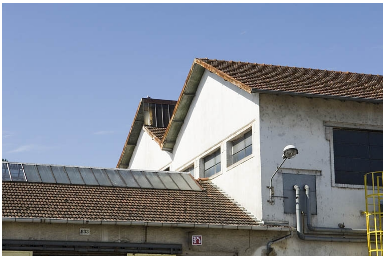
Toiture d'un magasin industriel.
