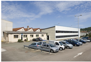
Atelier en rez-de-chaussée et bureaux. Phot. Jérôme Mongreville IVR43_20097000836NUC2A
