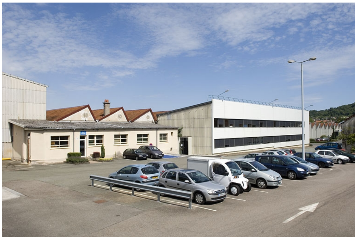
Atelier en rez-de-chaussée et bureaux.
