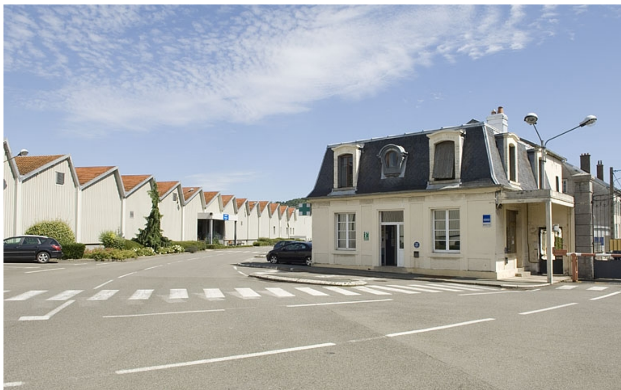
Atelier de fabrication et conciergerie (actuellement infirmerie).
