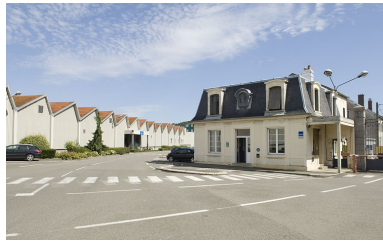
Atelier de fabrication et conciergerie (actuellement infirmerie). Phot. Jérôme Mongreville IVR43_20097000835NUC2A
