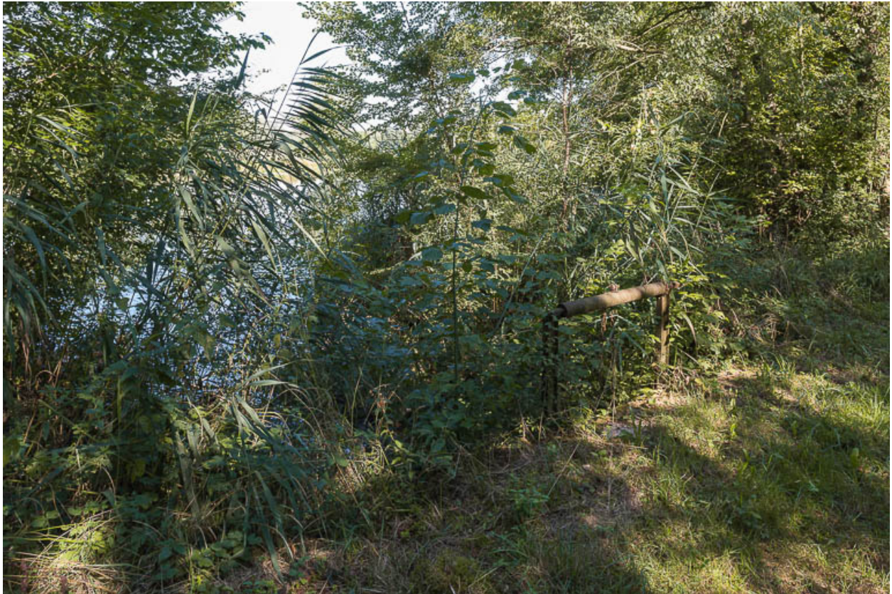
Vue de l'aqueduc.
