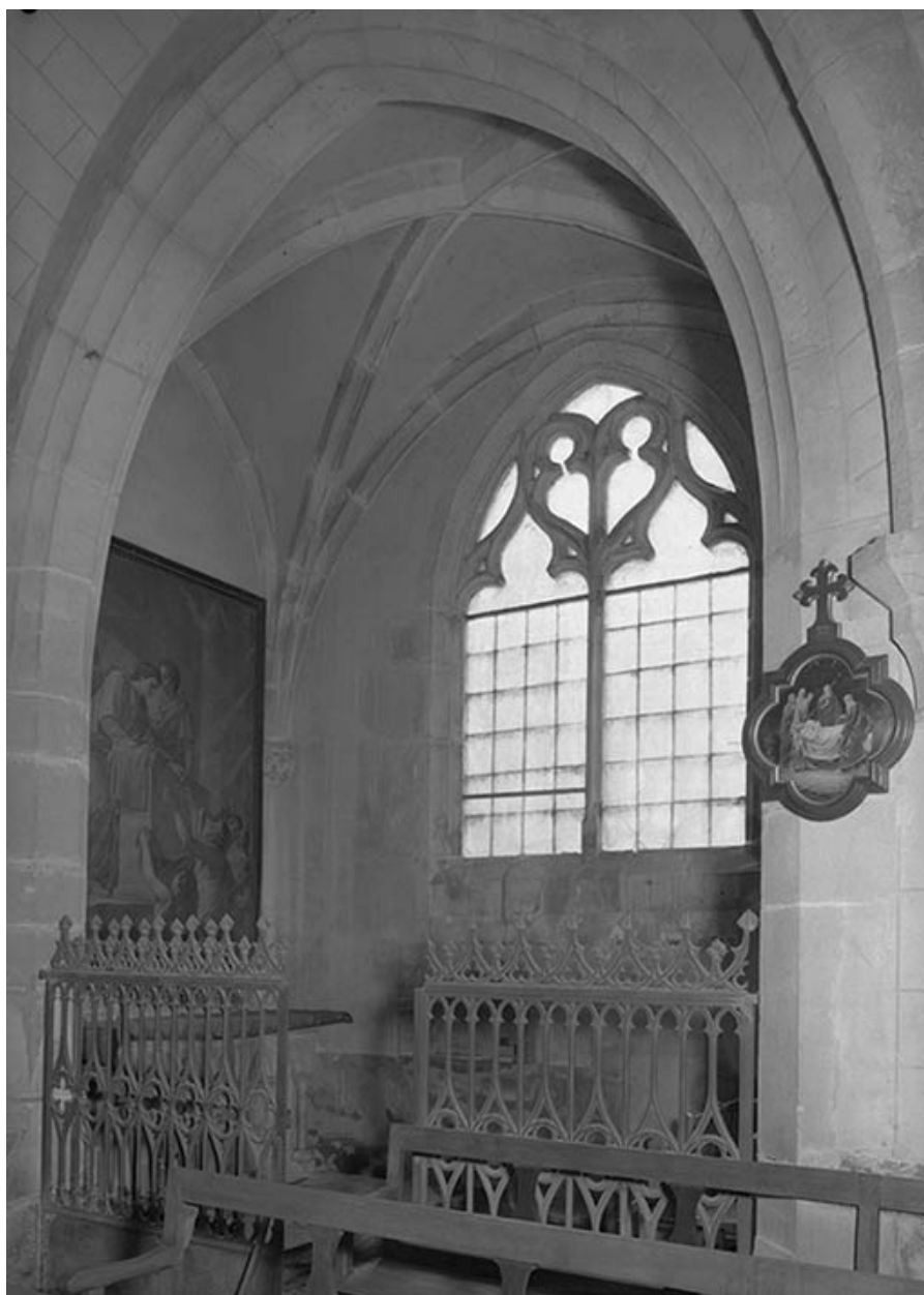
Chapelle latérale à croisée d'ogives.
