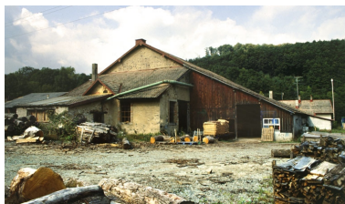
L'atelier de fabrication depuis le sud. Phot. Yves Sancey IVR43_19999000059ZA
