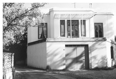
Façade antérieure avant restauration, novembre 1990. Phot. Yves Sancey, Autr. J.-P. Fillod IVR43_19943900006X
