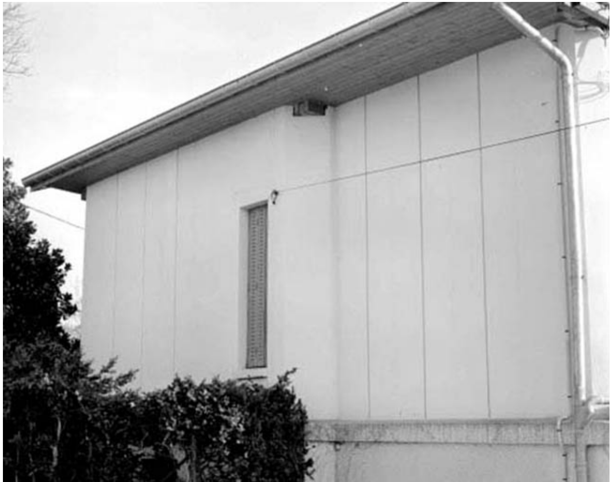
Façade latérale gauche : détail du mur.
