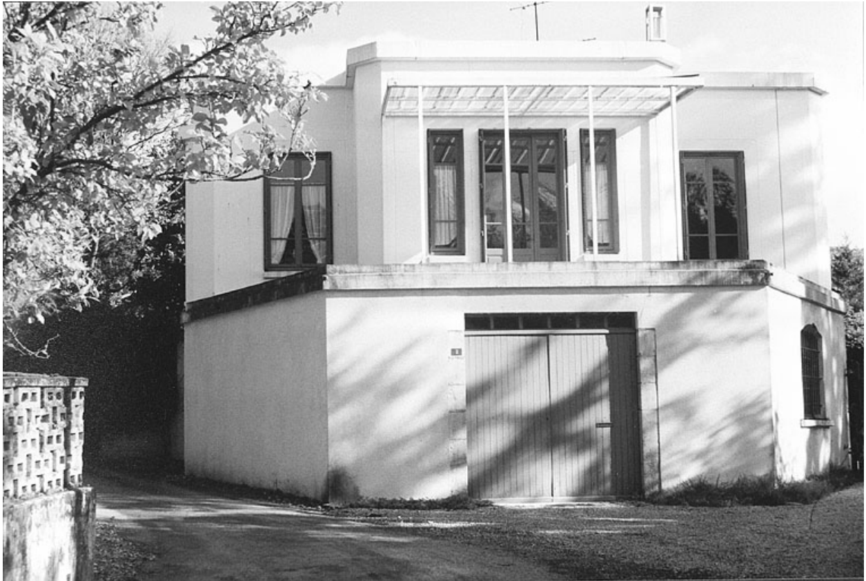
Façade antérieure avant restauration, novembre 1990.
