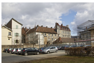
Vue d'ensemble éloignée de l'arrière de l'édifice.
