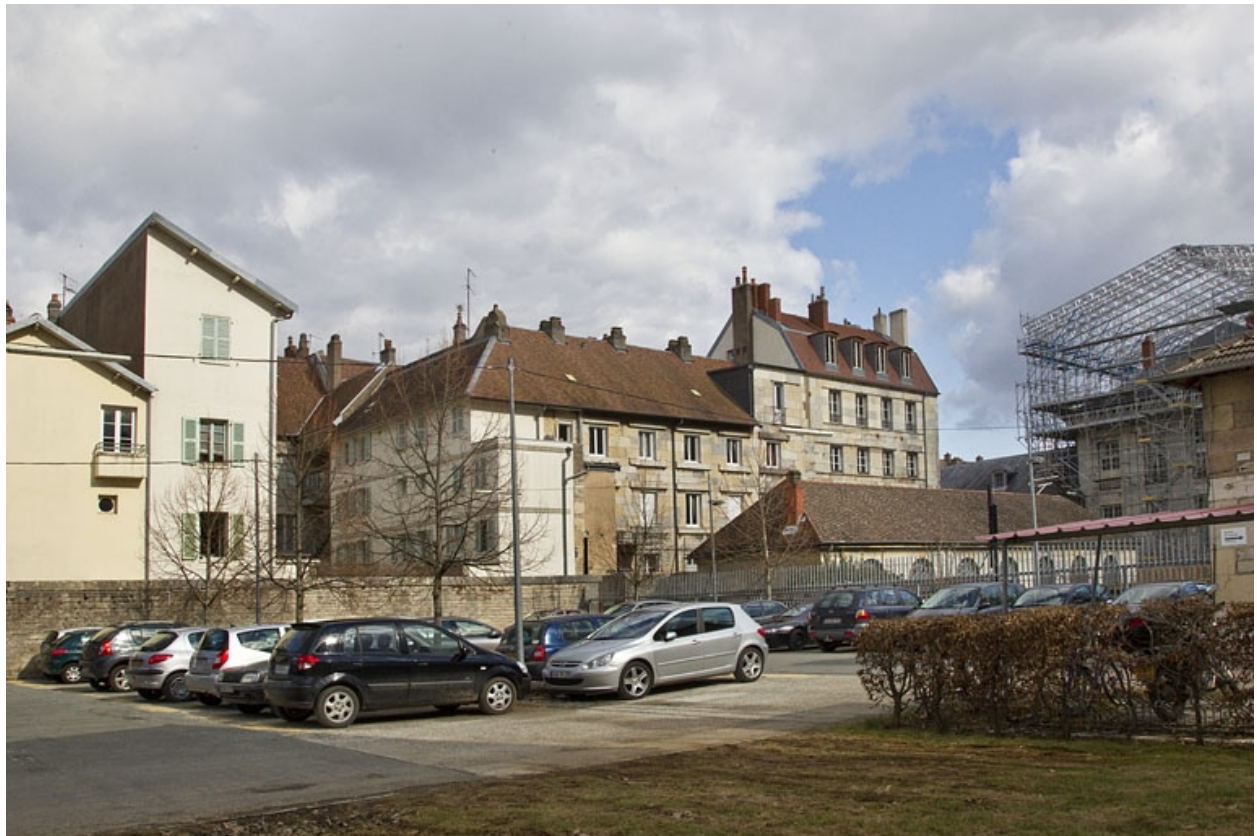
Vue d'ensemble éloignée de l'arrière de l'édifice.
