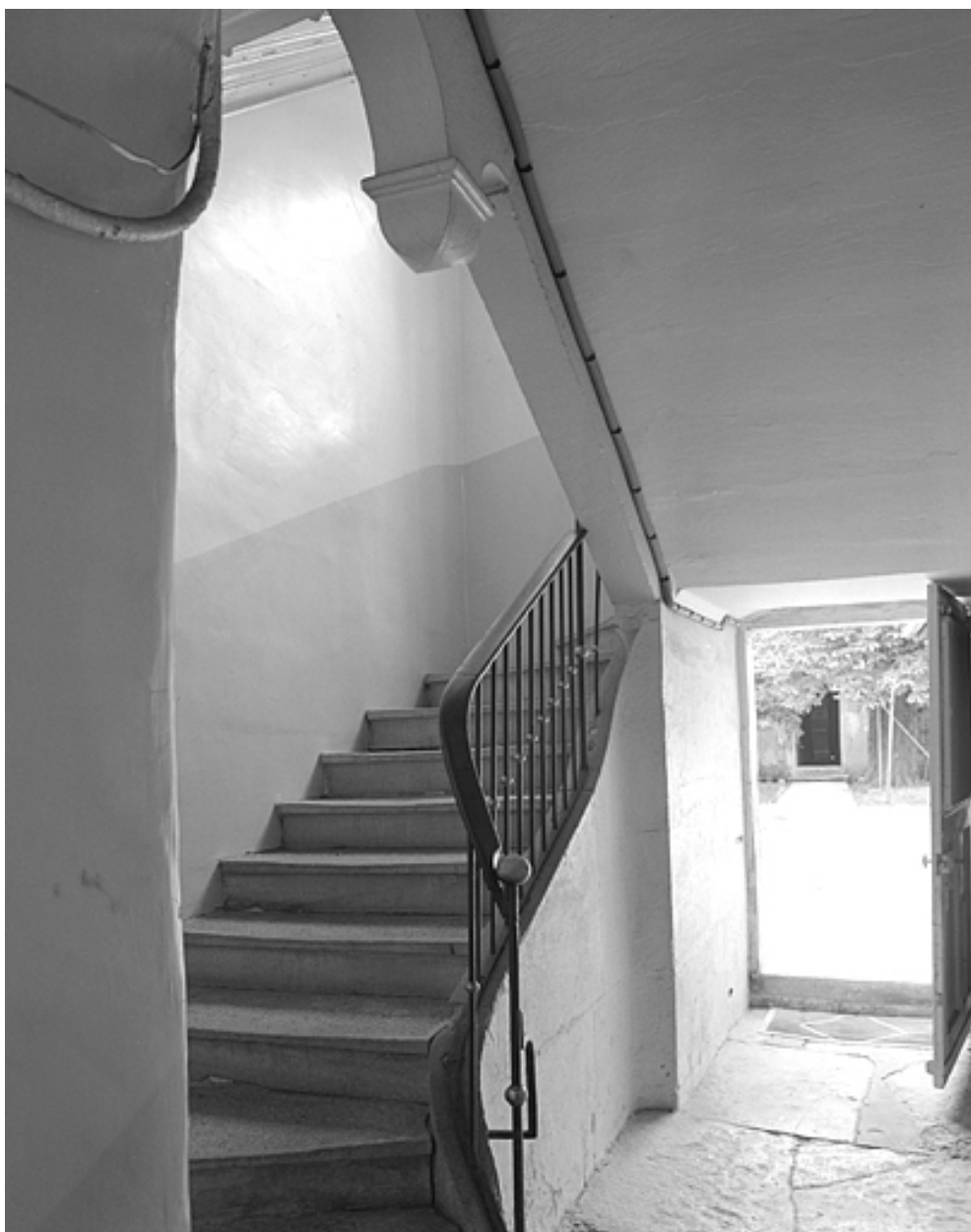
Escalier vu depuis le couloir.
