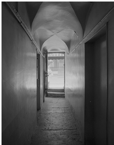
Couloir de communication entre la rue et la cour. Phot. Yves Sancey IVR43_19833900415X
