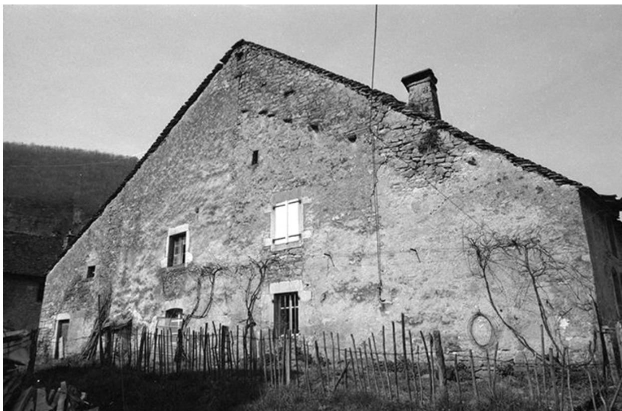
Ferme cadastrée 1964 AB 86 : façade sud.
