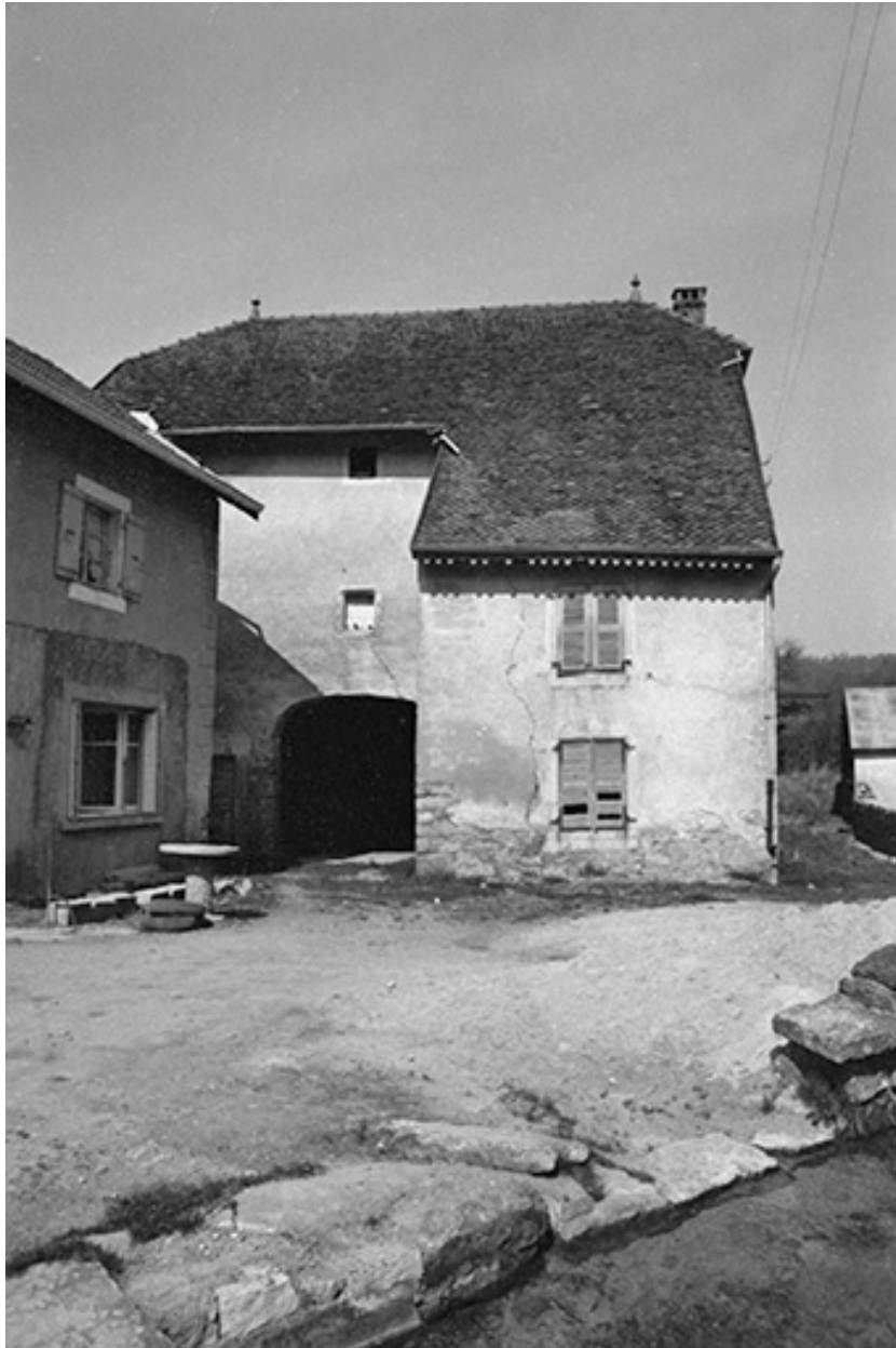
Maison cadastrée 1964 AB 106 : façade antérieure.
