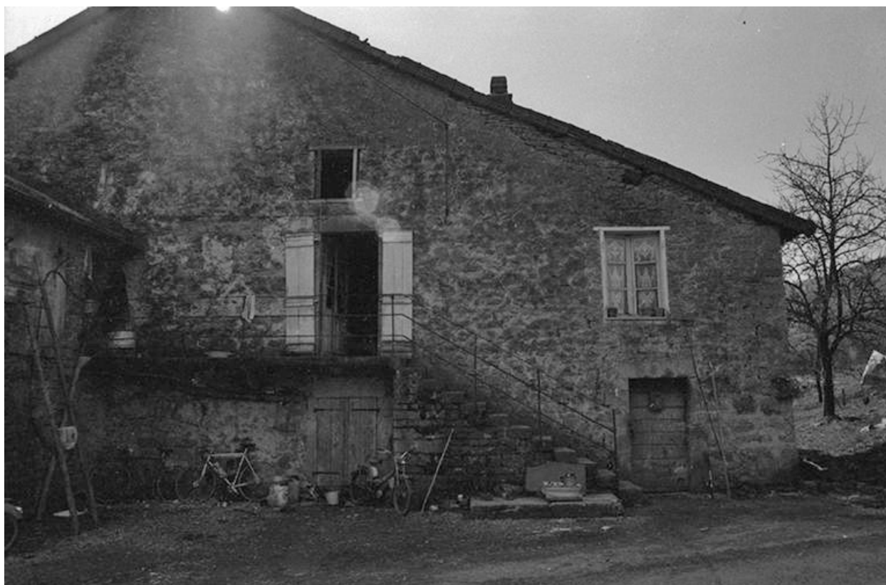
maison cadastrée 1964 AB 32 : façade antérieure.
