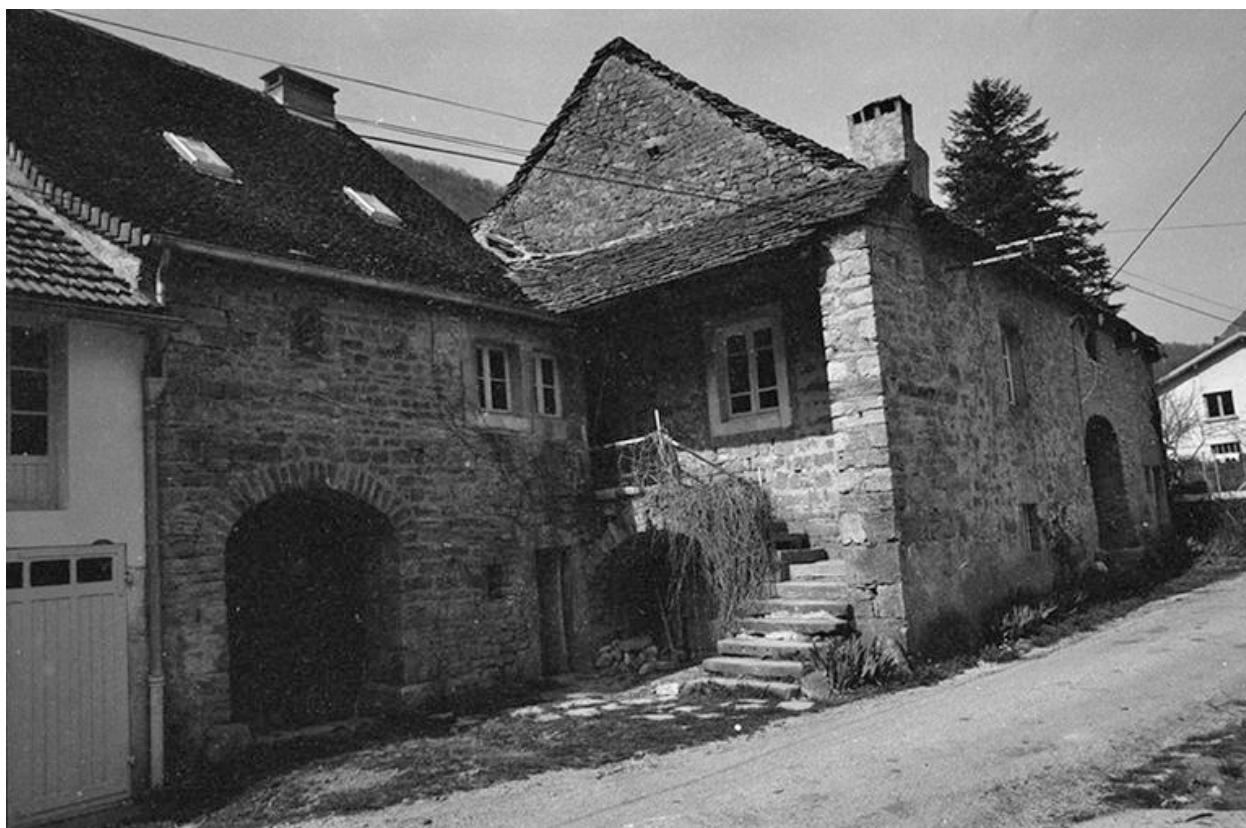
Ferme cadastrée 1964 AB : façade sur rue.
