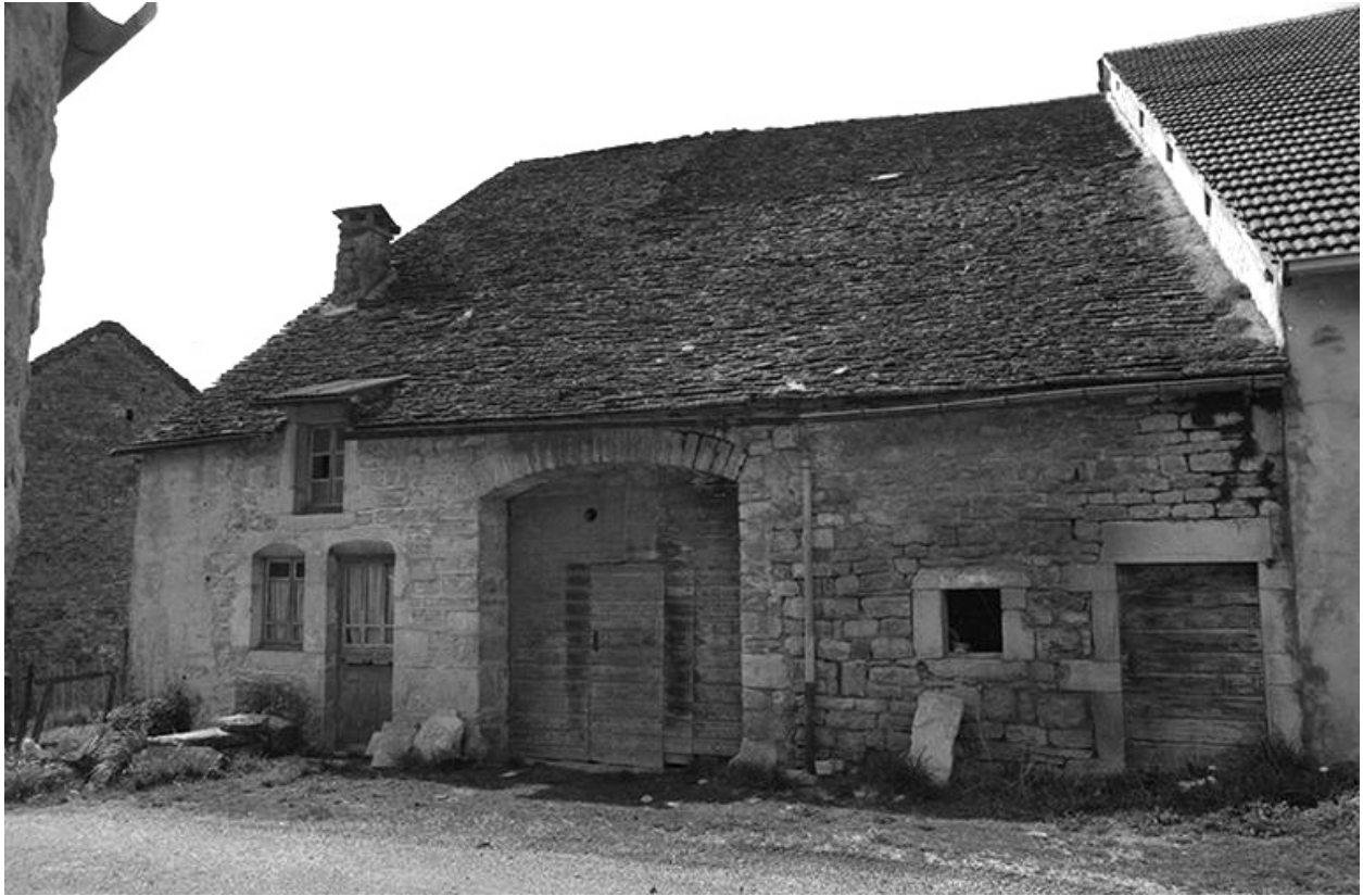
Ferme cadastrée 1964 AB 86 : façade est.
