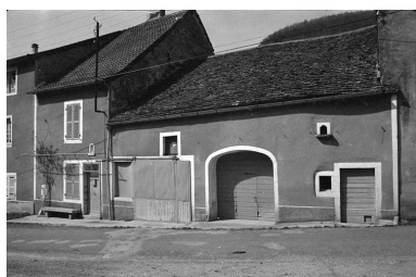
Ferme cadastrée 1964 AB 33 : façade antérieure. Phot. F. Pernin IVR43_19743900095Z
