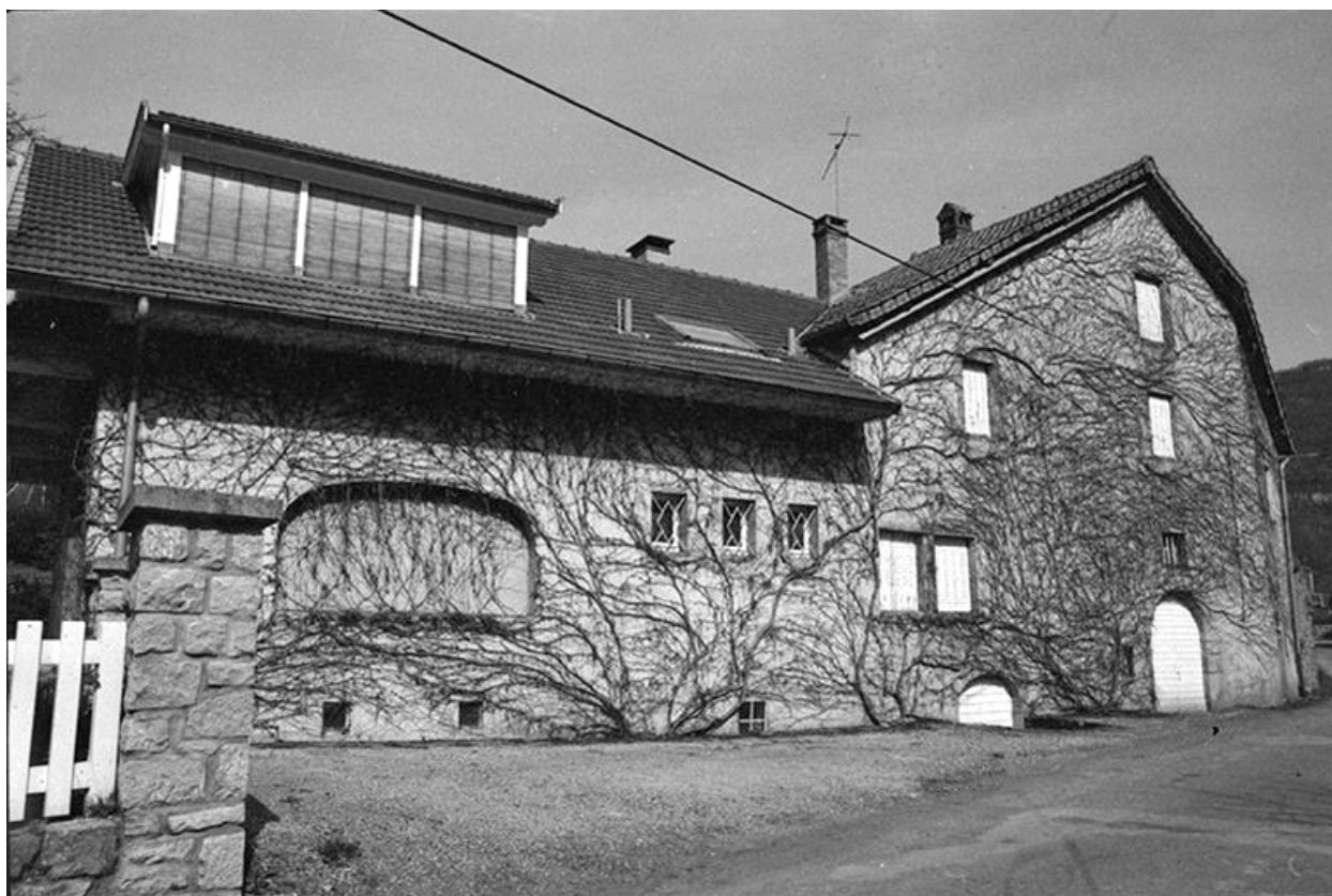
Maison cadastrée 1964 AB 13 : façade antérieure.
