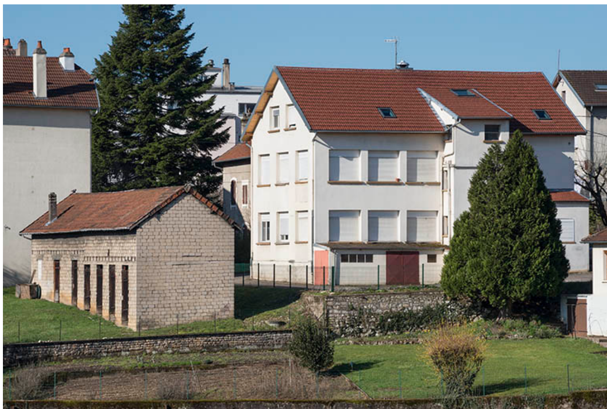
Façade postérieure depuis l'est.
